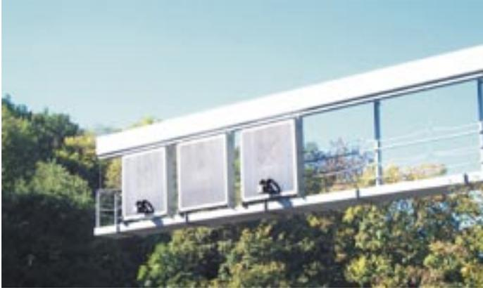
Abb.3: Kombiniertes Mikrowellen/Ultraschall-Detektor an einer Schilderbrücke der Verkehrsbeeinflussungsablage A4 Leutratal
