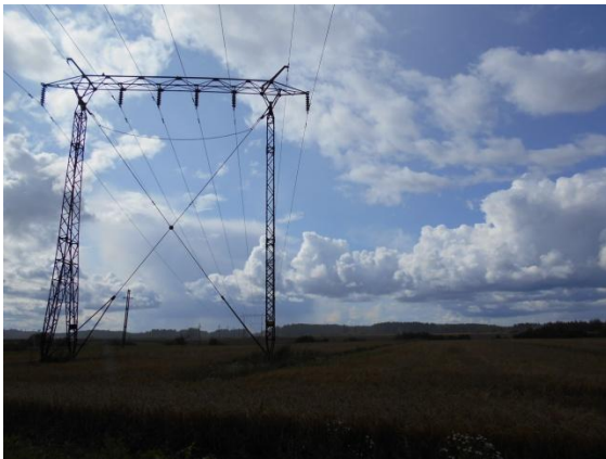
Kuva 7-2. Näkymiä voimajohtoreitille Kymijoen laakson valtakunnallisesti arvokkaalla maisema-alueella. Kymijoen puustoisella rannalla erottuu johtoaukea.
