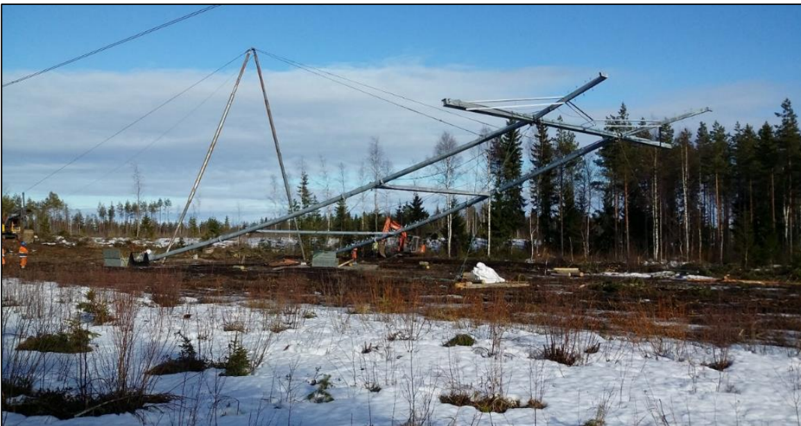
Kuva 9 Voimajohtopylvään pystytys.
