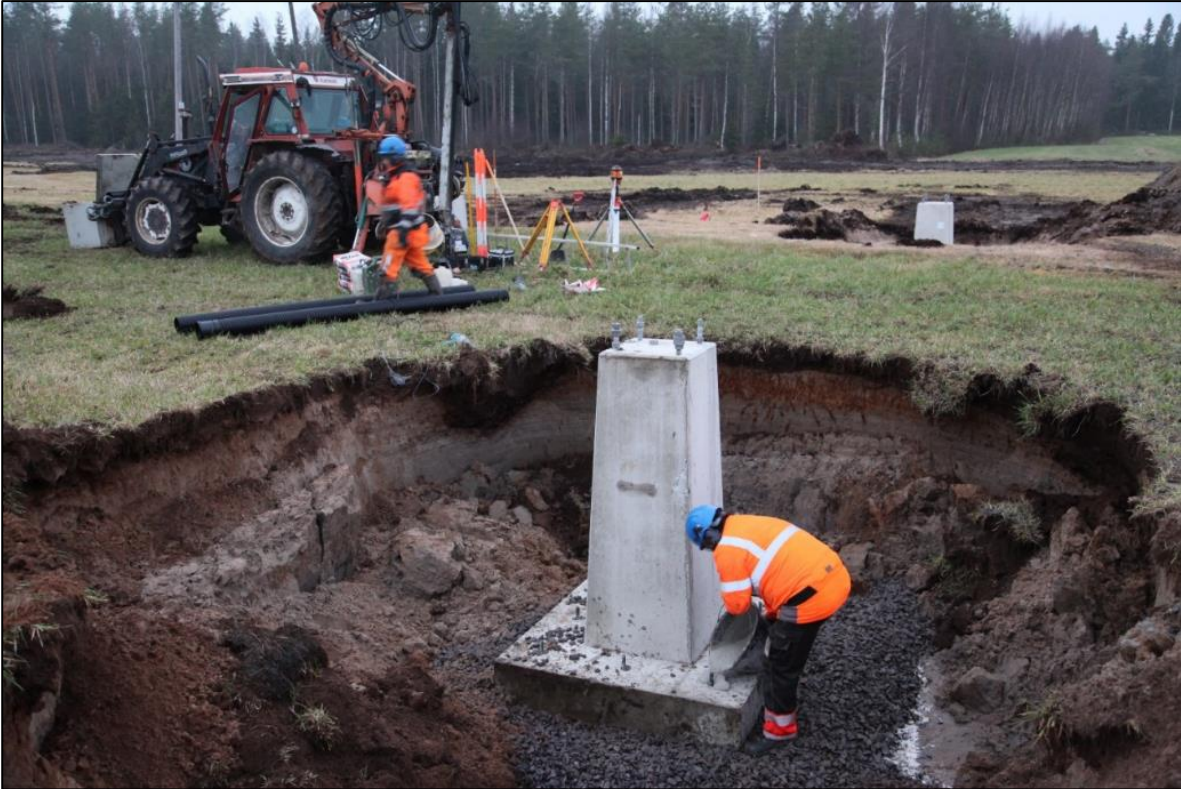
Kuva 7. Pylvään perustuselementin asentaminen.
