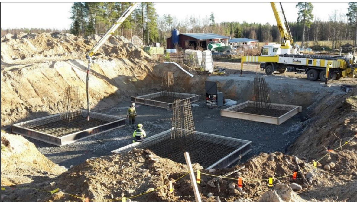
Kuva 8. Vapaasti seisovan pylvään perustustöitä.
