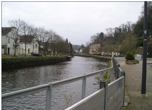
Photo 8: Dispositif de batardeaux Quai Brizeux, rive droite de la Laita - Quimperlé
