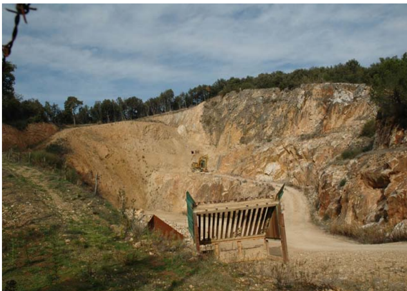
Fig. 4 - Cava attiva di marmo "Giallo Siena" denominata CANCELLO DEL PRETE nei pressi di Palazzo al Piano (Montagnola Senese).
