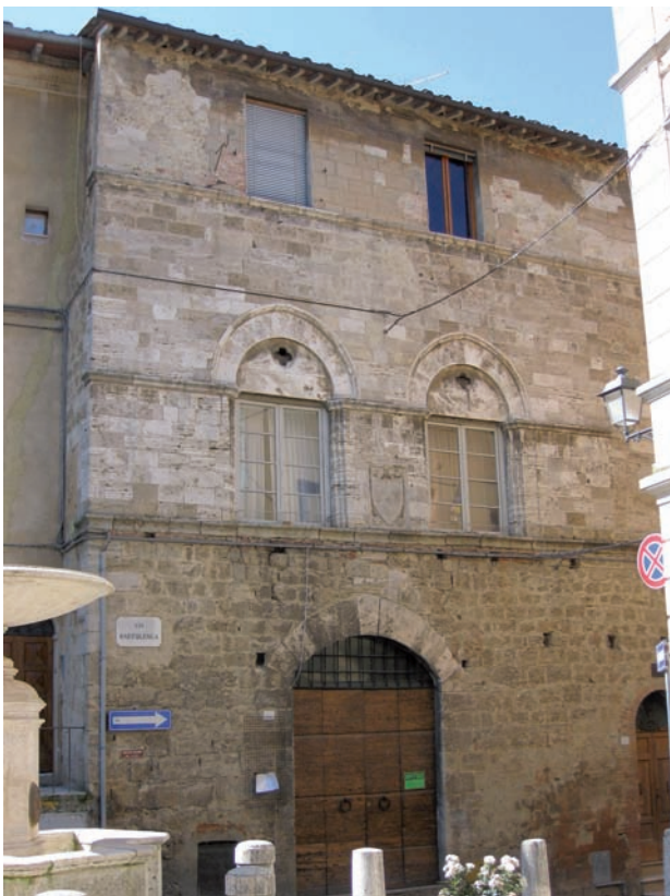
Fig. 15 - Facciata del Palazzo Tolomei in Asciano (Siena). La struttura portante, di colore giallastro, è costruita con blocchetti di calcareous tufa , mentre il rivestimento del piano nobile con bifore, di colore bianco, è in travertino.
