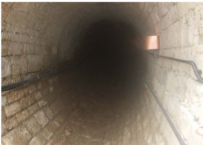
Fig. 2 - L'inattiva miniera di lignite a Velona (Montalcino). Ingresso della discenderia, recentemente bonificato dai detriti.
