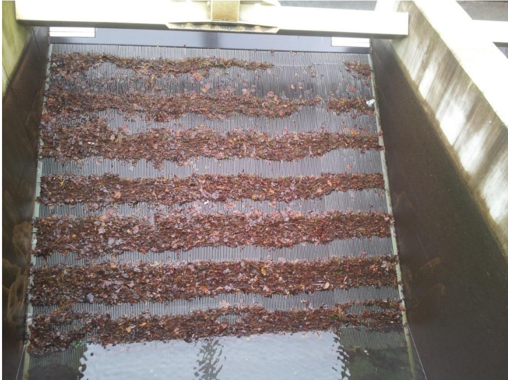
Abbildung 26: Teilverlegter Rechen 2 (Ansicht von vorne, November 2014)
