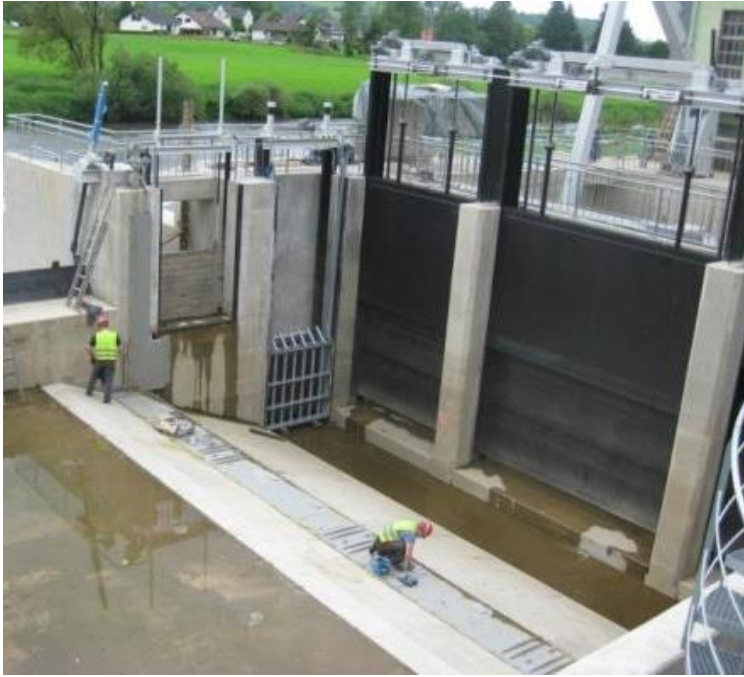
Abbildung 16: Einbau der BottomGallery
