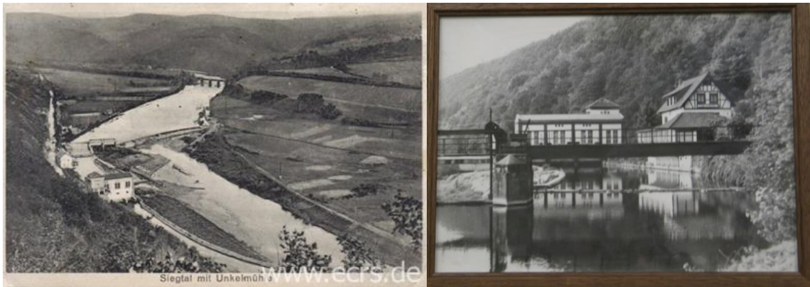
Abbildung 2: Wasserkraftanlage Unkelmühle in früherer Zeit, Quelle: innogy SE
