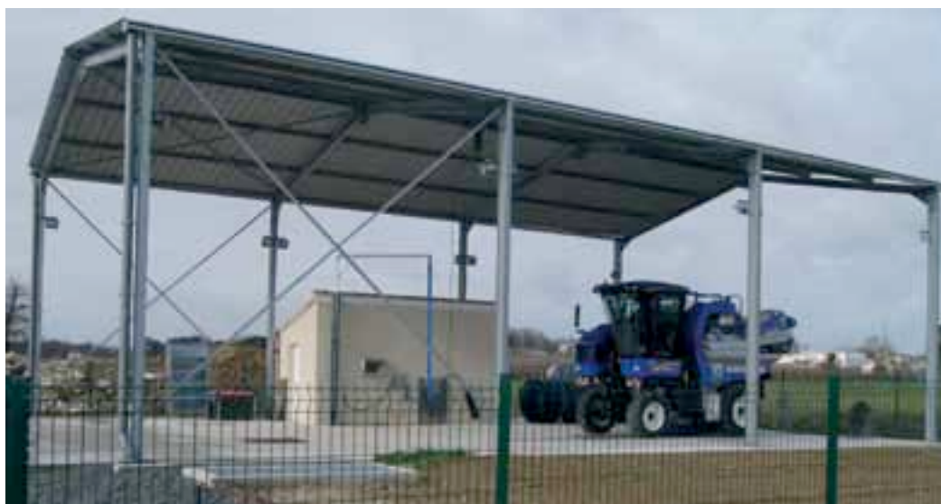
Au terme d'un projet initié en 2008, la Sarl Decouzon « Locagri » met à disposition des exploitants une installation permettant le remplissage et le lavage des pulvérisateurs, le retraitement des effluents phytosanitaires, ou encore le lavage des machines à vendanger dans le respect des normes en vigueur.
