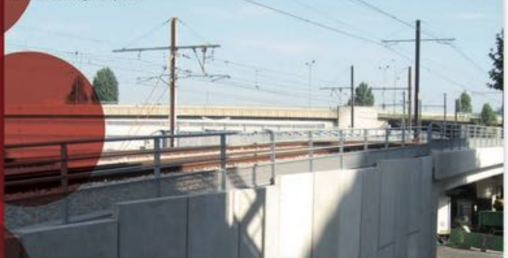
Tramway T2 à Issy Les Moulineaux - Murs de rampe TerraSet® Maitre d'ouvrage RFF/RATP
