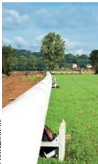
Les tubes sont préparés en bordure du tracé avant que la tranchée ne soit creusée.
