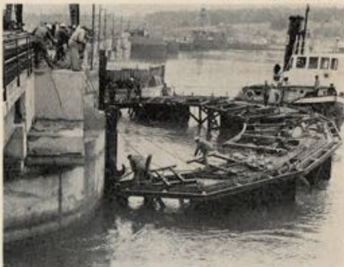
Fig. 40. — Construction des cellules. Gabarit en cours d'accrochage.
