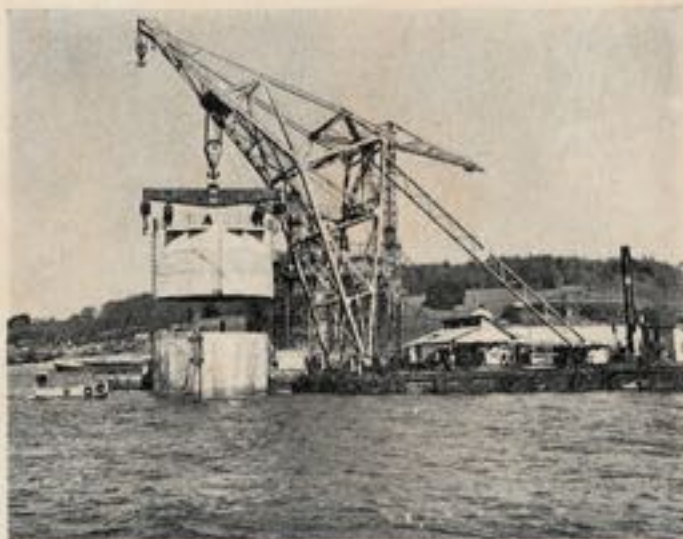
Fig. 37. — Superstructure d'un caisson.
