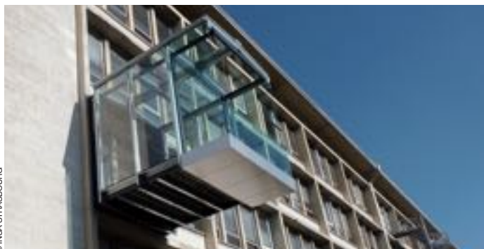
Prototype du balcon améliorant les performances thermiques d'une façade à simple vitrage.
