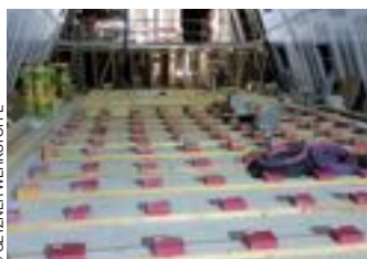
Pose des plots anti-vibratoires au sol de l'auditorium du pavillon Dufour.
