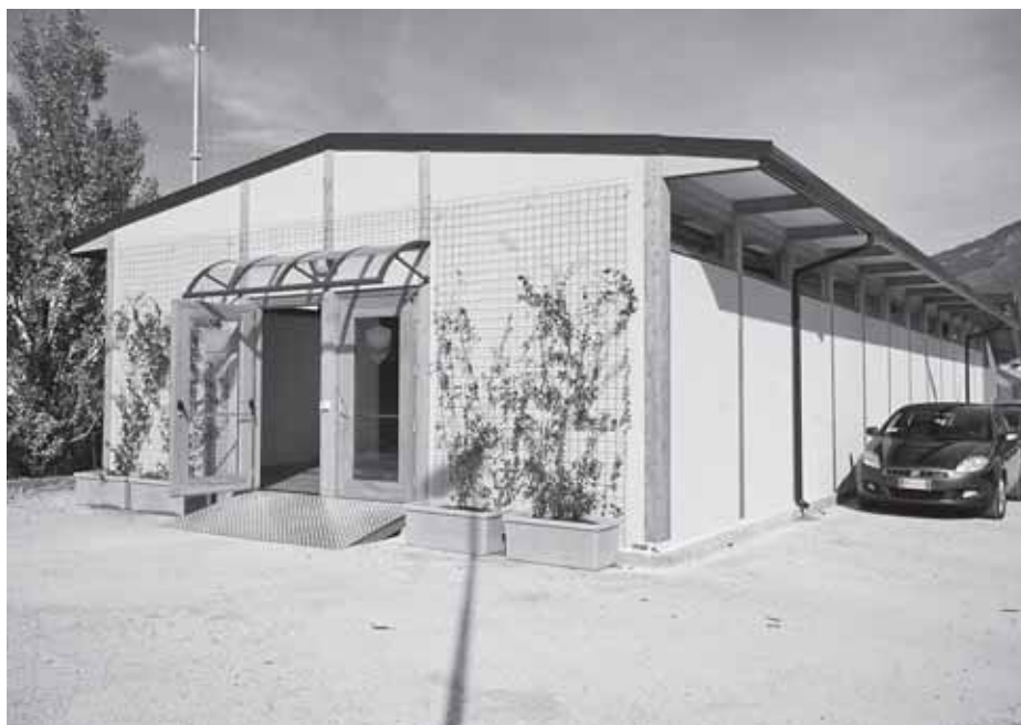
Il nuovo padiglione eco-sostenibile della Facoltà di Ingegneria dell'Aquila.
