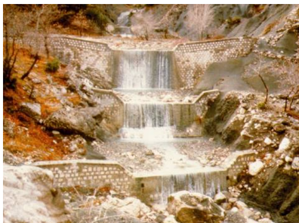
Φράγματα στερέωσης της κοίτης στο χειμαρρικό ρεύμα "Καταρράκτης" στην Πίνδο
