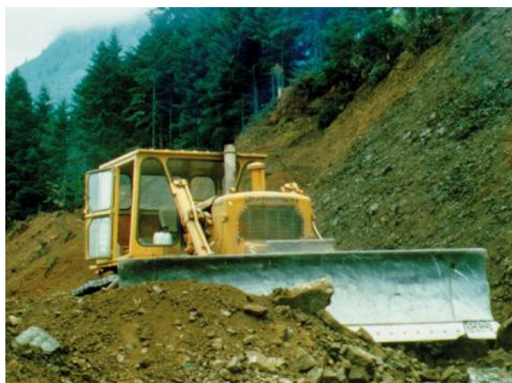
Διάνοιξη δασικού δρόμου
