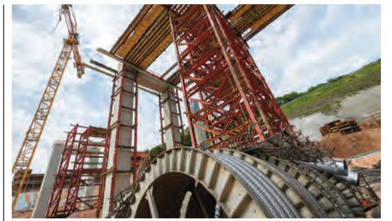
Uno degli imponenti cantieri autostradali con lavori in corso.
