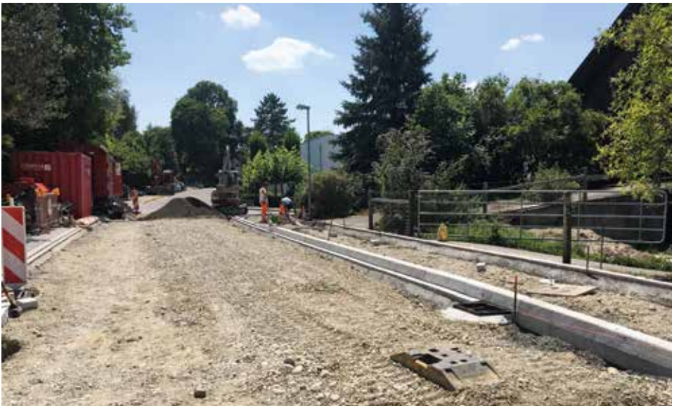
Arbeiten an der behindertengerechten Bushaltestelle der General-Weber-Strasse.
