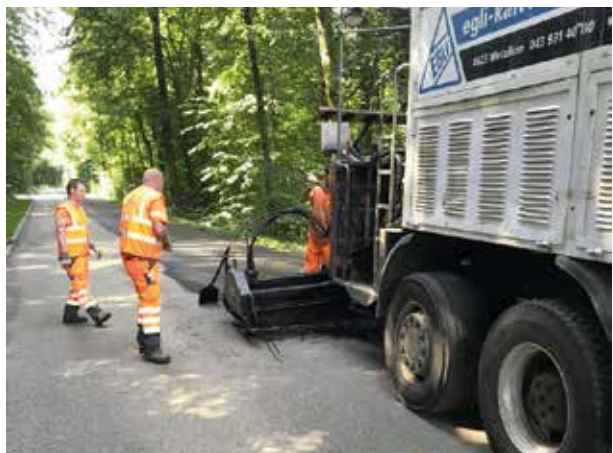
Einbau Dünnschichtbelag auf der Gerlikonerstrasse.
