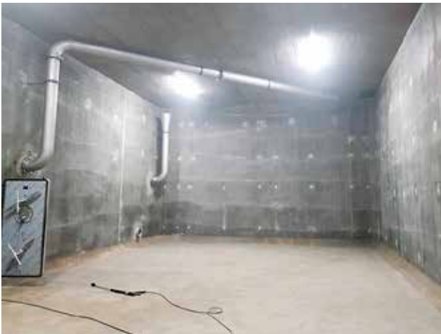
Neue Wasserkammer Reservoir Stählibuck.
