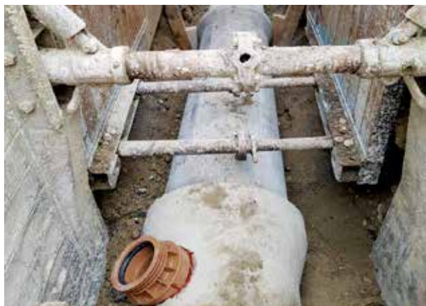
Kanalisationsleitung im gespriessten Graben im Allmendweg.
