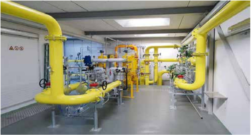
Reduzierstation Gaswerk
