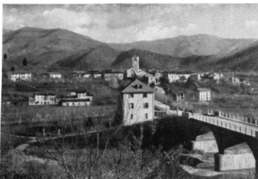
Nimis e i suoi colli. In primo piano, il ponte sul torrente Coraippo.
