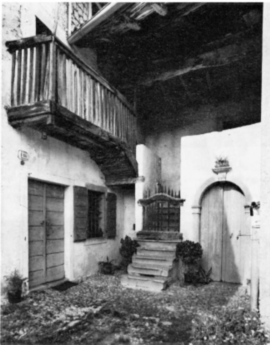
Interno di un tipico cortile friulano nella pedemontana: abbandonato per tanti motivi, oggi è al limite della sopravvivenza. Eppure queste erano, fino a qualche anno fa, le case stupende della gente del Friuli. (Foto Ciol - Casarsa)
