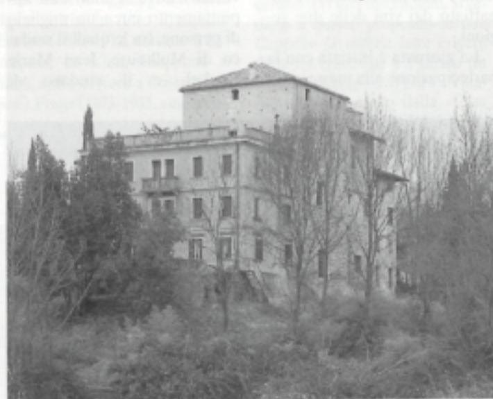
Pordenone, Torre: Il Castello.
