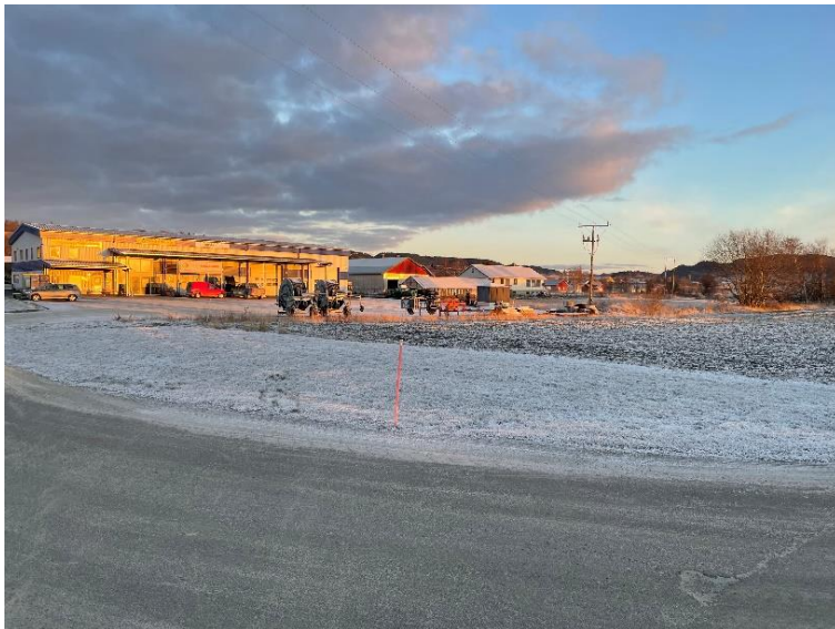
Bildet viser høgspenning i luftlinje
