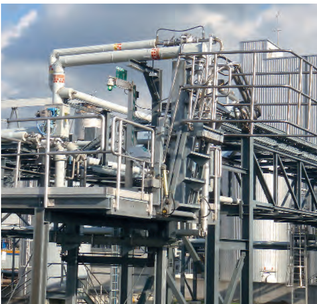
Tanknotdusche in Leitung eingeschliffen / Freier Auslauf DIN 1717
