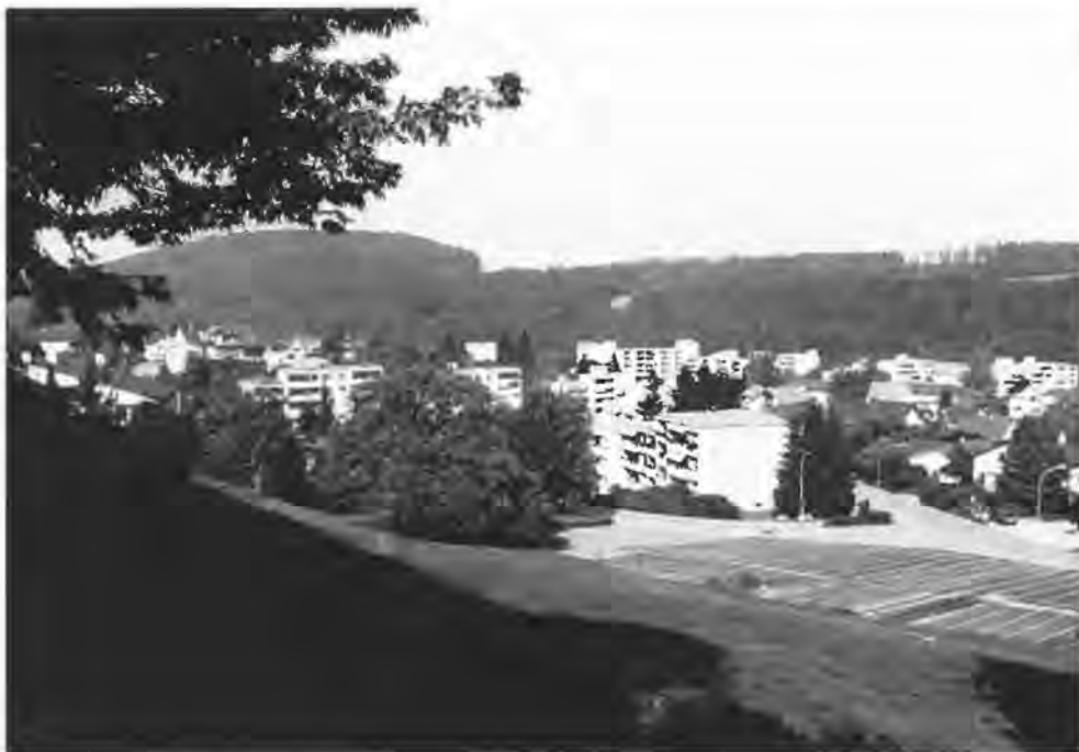
Links die Flarzhäuser auf dem Rütibühl, in der Mitte der einstige Zopf, rechts der Grund.
