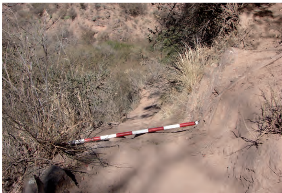
Figura 4. Segmento de camino con talud y excavación dentro de la ladera (Fotografía de R. A. Moralejo).
