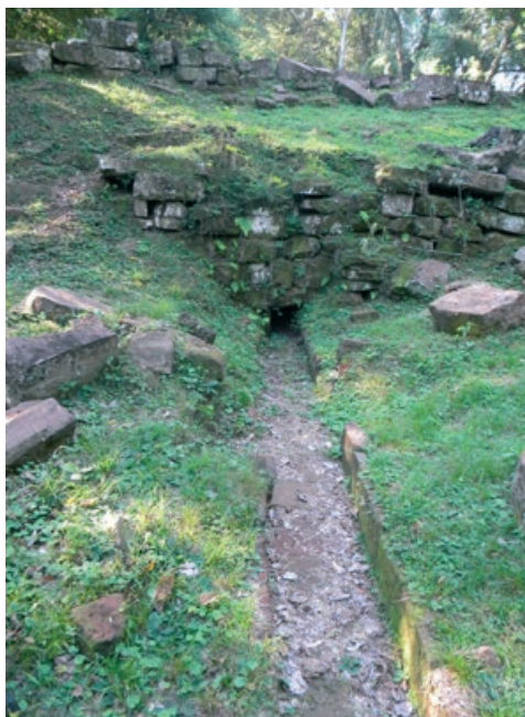
Figura 11. Vista de parte del sistema de circulación de agua de la reducción de Santa Ana.
