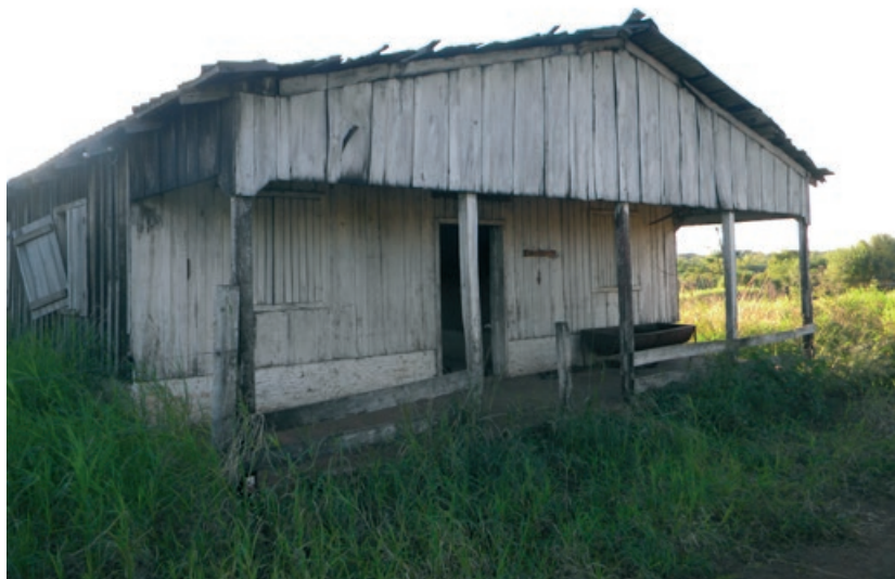
Figura 10. Vivienda de madera en el camino de acceso de Campo San Juan (2012).
