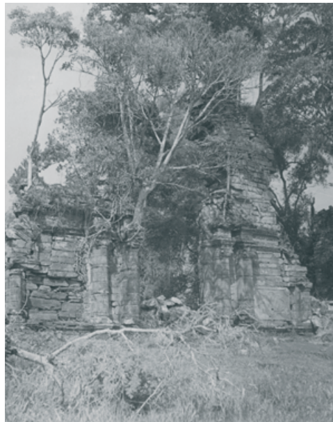
Figura 15. Vista del portal principal de San Ignacio en 1934, antes de su restauración y reconstrucción (Fuente: Archivo General de la Nación Argentina).
