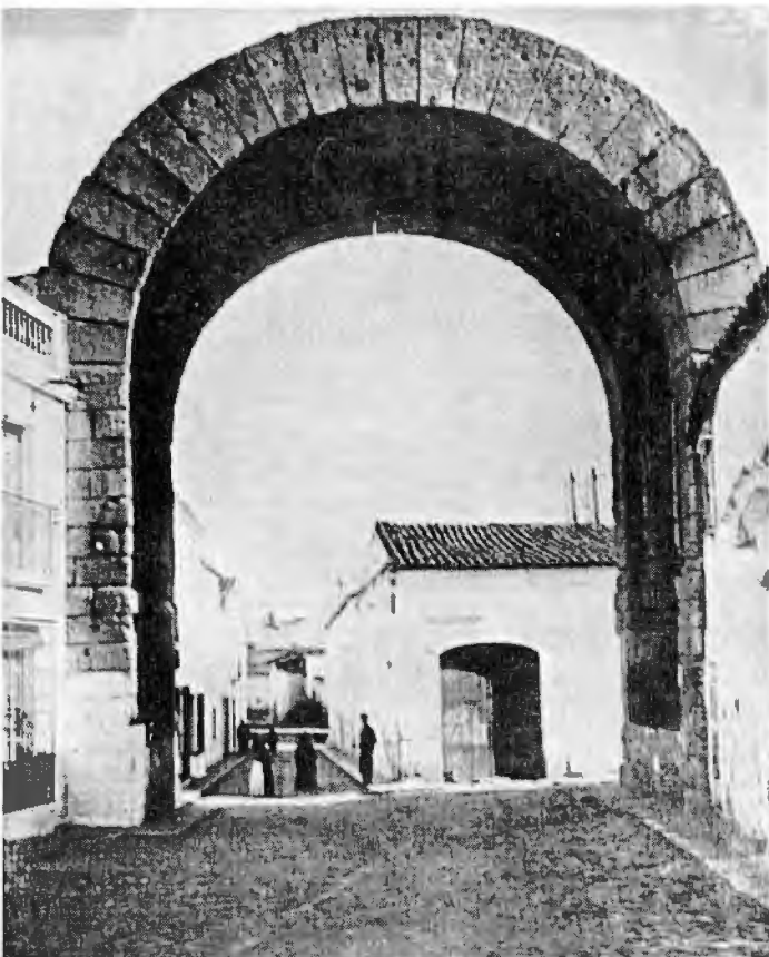
Fig. 11. Mérida. Arco llamado de Trajano, pero en realidad, puerta de la muralla augustea. Mide 15 metros de altura y presenta un robustísimo dovelaje de tradición republicana, con oquedades para elevar las dovelas.
