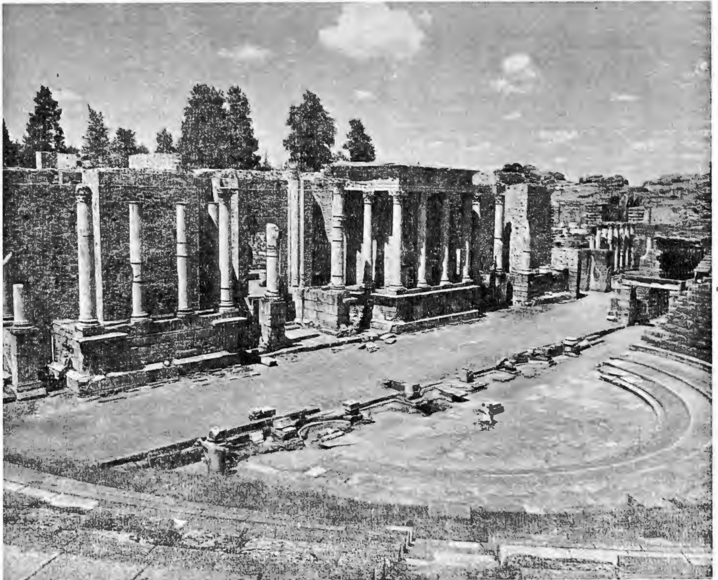
Fig. 19. Teatro de Mérida. Frons scaenae con sus tres valvae y estatuas entre algunas columnas, pulpitum infraestructura del proscaenium, orchestra, ina cavea y parte de la media.
