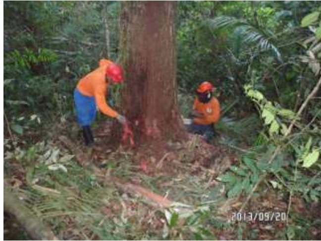
Figura 26 – Limpeza da base de árvore a ser derrubada
