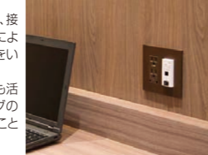
パブリックスペースに設置された無線 AP「AE1021」
