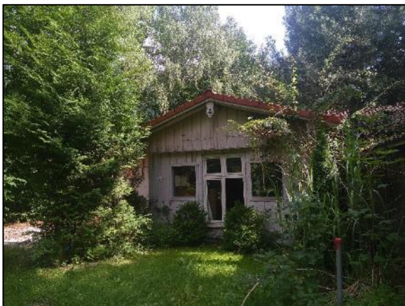
Bild 5: Anbau ehemaliges Sanitärgebäude (19.07.2021).
