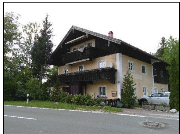
Bild 10: noch bestehendes Wohngebäude (19.07.2021).
