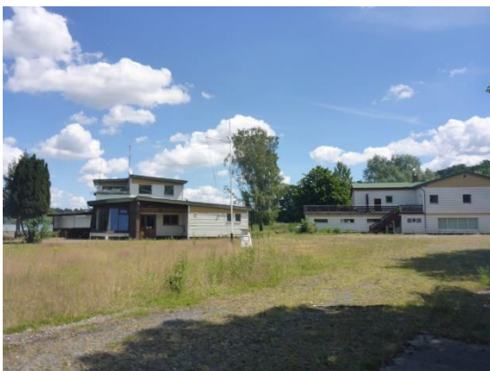
Abb. 8 Blick von Westen auf beide Gebäude.
