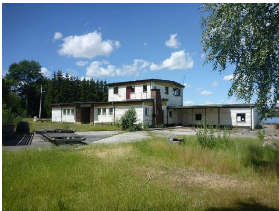
Abb. 6 Gebäude im Norden des Plangebiets.
