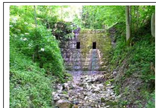
Wildbachverbauung am Weberbichlgraben, Marktschellenberg
