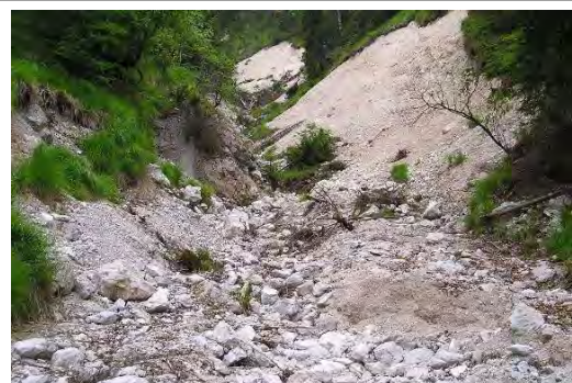
Geschiebetransport Fleischkellergraben, Markt Berchtesgaden
