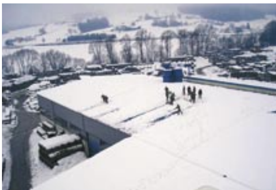
Schneemassen werden vom Dach einer Industriehalle entfernt (6. Jänner 2006)
