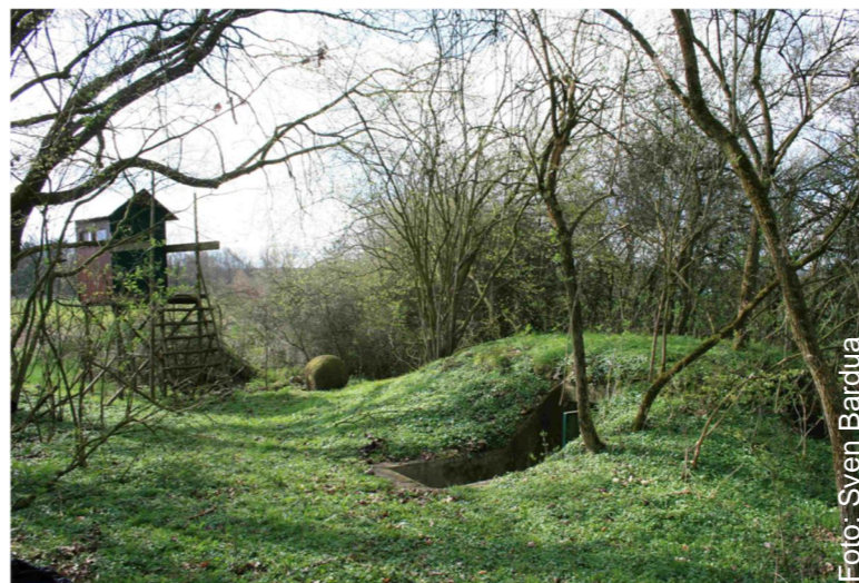
Der Widder befindet sich in einem halb in die Erde eingelassenen Pumpenhaus.
