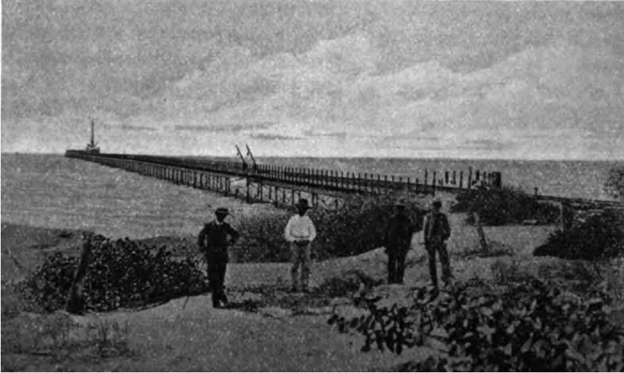
✧ Muelle marítimo en Puerto Colombia
