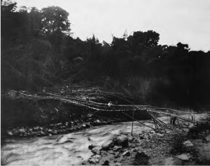
☞ Puente de bambú sobre el río Chinchiná
