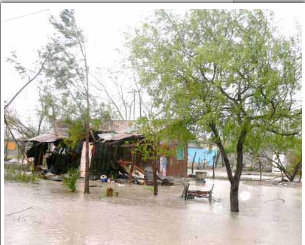
Figura 4-5. Daños provocados por el huracán Emily, de julio de 2005, en Soto de la Marina, Estado de Tamaulipas, México (JPC, 2005)
