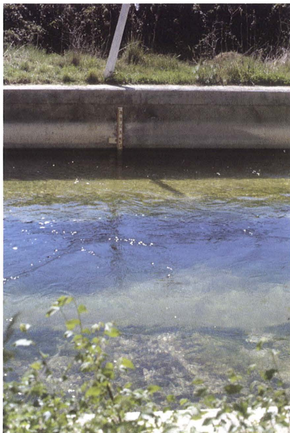
Foto 1.9. La medida indirecta de caudales se realiza a través de las medidas del nivel del agua en una escala. Foto: Estación de aforos de La Cubeta, Ruidera (Ciudad Real), 1997.
