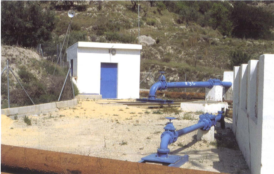
Foto 3.3. El bombeo simultáneo de dos pozos en un mismo acuífero crea una interferencia que tiene como resultado que el descenso real es la suma algebraica de los descensos que producirían los bombeos en cada uno de los pozos individualmente. Foto: Pozos de abastecimiento a la Marina Baja, Beniardá (Alicante), 1998.
