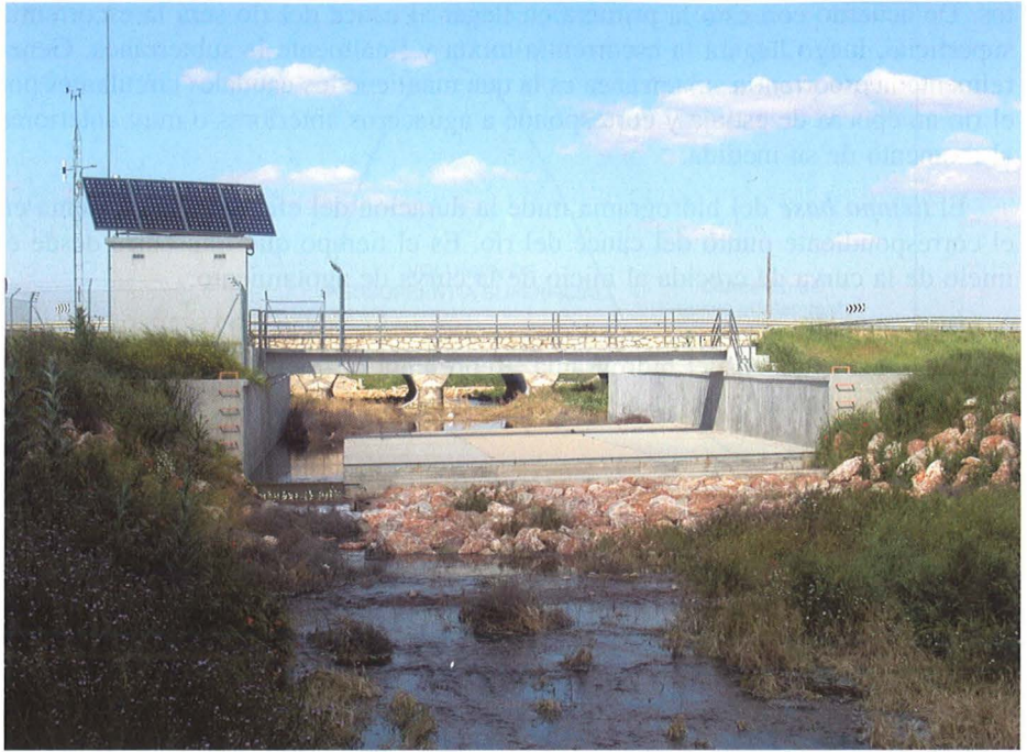
Foto 1.8. Las estaciones de aforos de escorrentía superficial se instalan en tramos de cauce especialmente preparados para la medida directa o indirecta de los caudales de agua que circulan por el mismo. Pueden tener varias secciones, para caudales en aguas altas y caudales en aguas bajas, y diversos instrumentos asociados, como escalas o limnigrafos. Foto: Estación de aforos del río Záncara; Carretera Alcázar de San Juan-Tomelloso (Ciudad Real), 2004.
