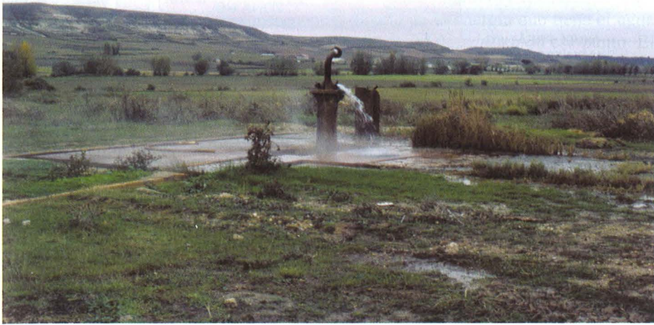
Foto 2.2. La perforación de sondeos en acuíferos confinados puede dar lugar a pozos surgentes, como el existente en Hormaza (Burgos) que penetra en materiales mesozoicos sobre el que se sitúan otros terciarios de conductividad hidráulica mucho menor. La gran profundidad del sondeo (del orden de 2000 m) y el rápido ascenso del agua por éste origina que la temperatura de surgencia sea muy elevada. Foto: Hormaza (Burgos), 1997.
