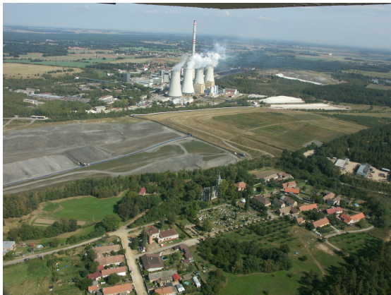
Obr. č. 20. Elektrárna Chvaletice
