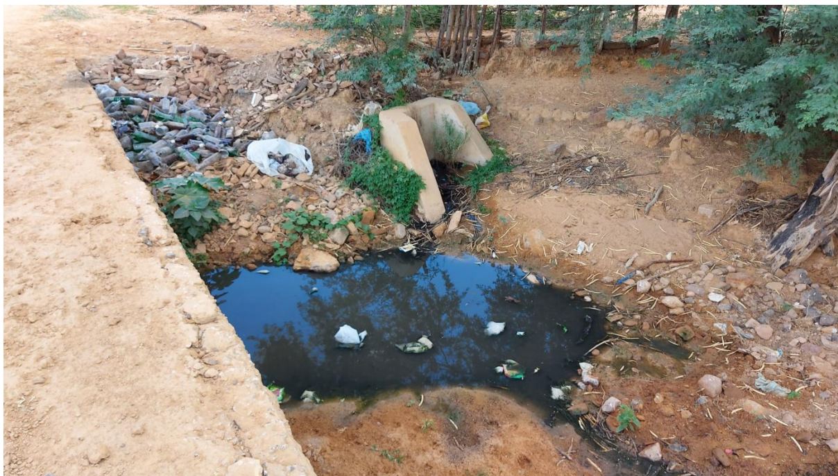
Figura 26 - Esgoto no Distrito de Moxotó Fonte: Instituto Gesois, 2020.
