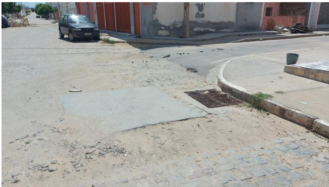
Figura 36 - Boca de Lobo Fonte: Instituto Gesois, 2020.
