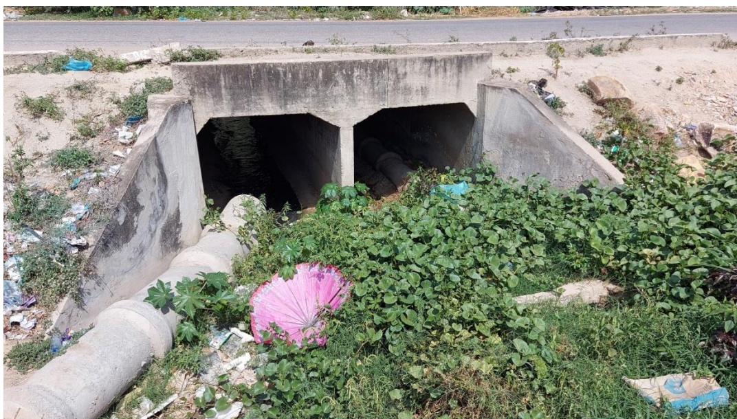
Figura 37 - Bueiro Duplo Celular de Concreto Fonte: Instituto Gesois, 2020.
