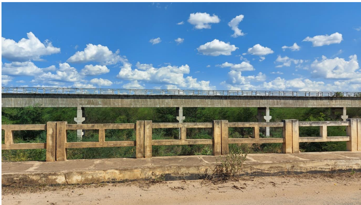
Figura 23 - Canal do Perímetro Irrigado do Moxotó Fonte: Instituto Gesois, 2020.
