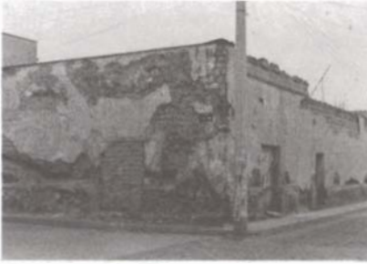
Figura 7. Casa colonial en Chalco.
