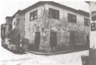
Construcción de dos niveles en el sistema de Bahareque, Santo Tomás Chichicastenango.
