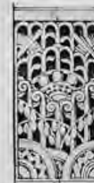
Terra Cotta Spandrel
