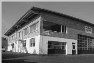
Elementbau, Fassade, Fenster
