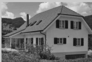
Wintergarten, Dach, Innenausbau
