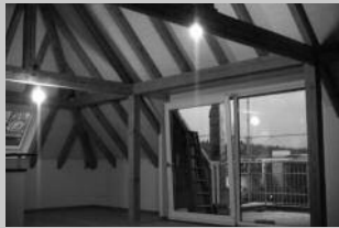
Dach, Innenausbau, Fenster
