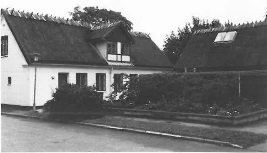
Søndergård, Bagsværds sydligste gård, blev bevaret som fælleshus, da bebyggelsen Søndergård Park blev opført i 1950'erne. Stuehuset og en enkelt af udbygningerne ses i 1993 – smukt bevaret med stråtag – i dag med adresse på Huginsvej 20.
