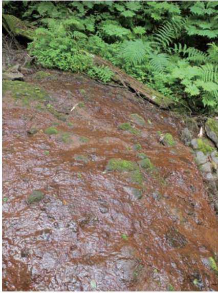
図2-4 河床に露出する安山岩質凝灰角礫岩
