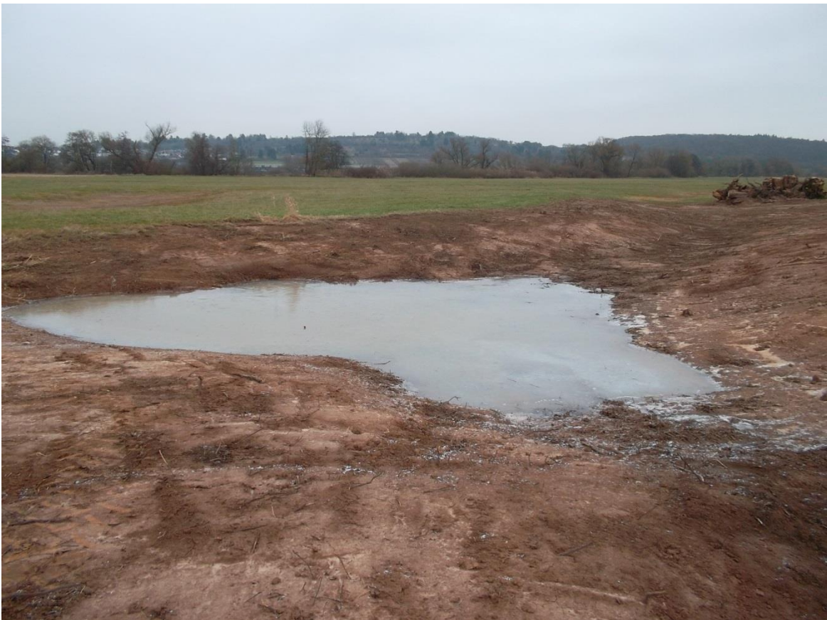
Abb. 60: Der hintere Teil des neuen Gewässerkomplexes 1 nach der Fertigstellung © GNA
