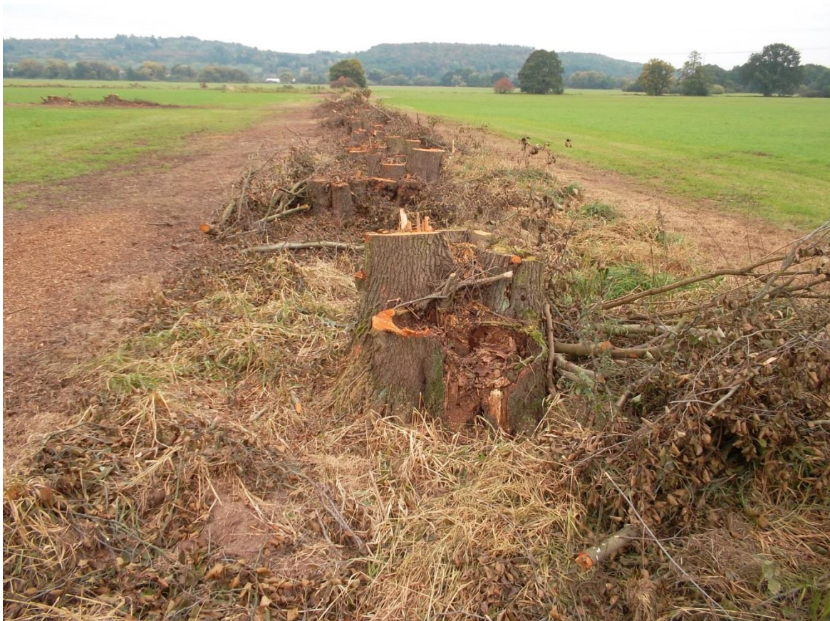
Abb. 50: Die Wurzelstöcke wurden zunächst im Erdboden belassen. © GNA
