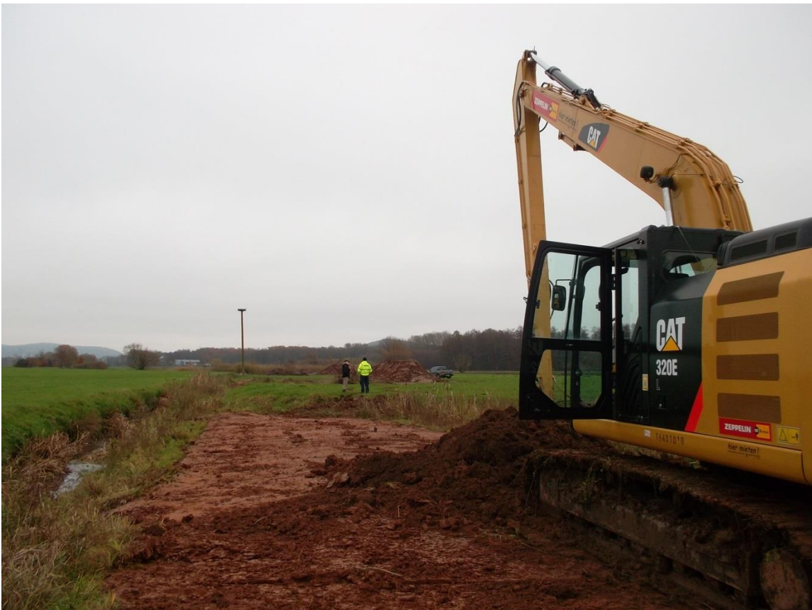
Abb. 85: Die Arbeiten schreiten voran. Der Aushub wird am Bachrand gelagert, da ein Abfahren nicht möglich ist. 16.11.2017 © GNA
