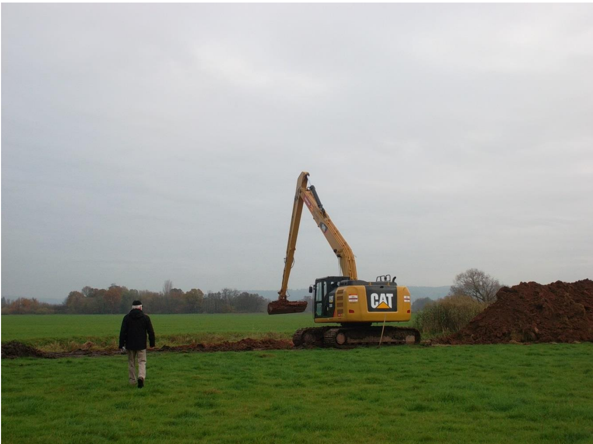
Abb. 78: Der Gewässerkörper wird entkrautet und die Ufer werden abgeflacht 14.11.2017. © GNA
