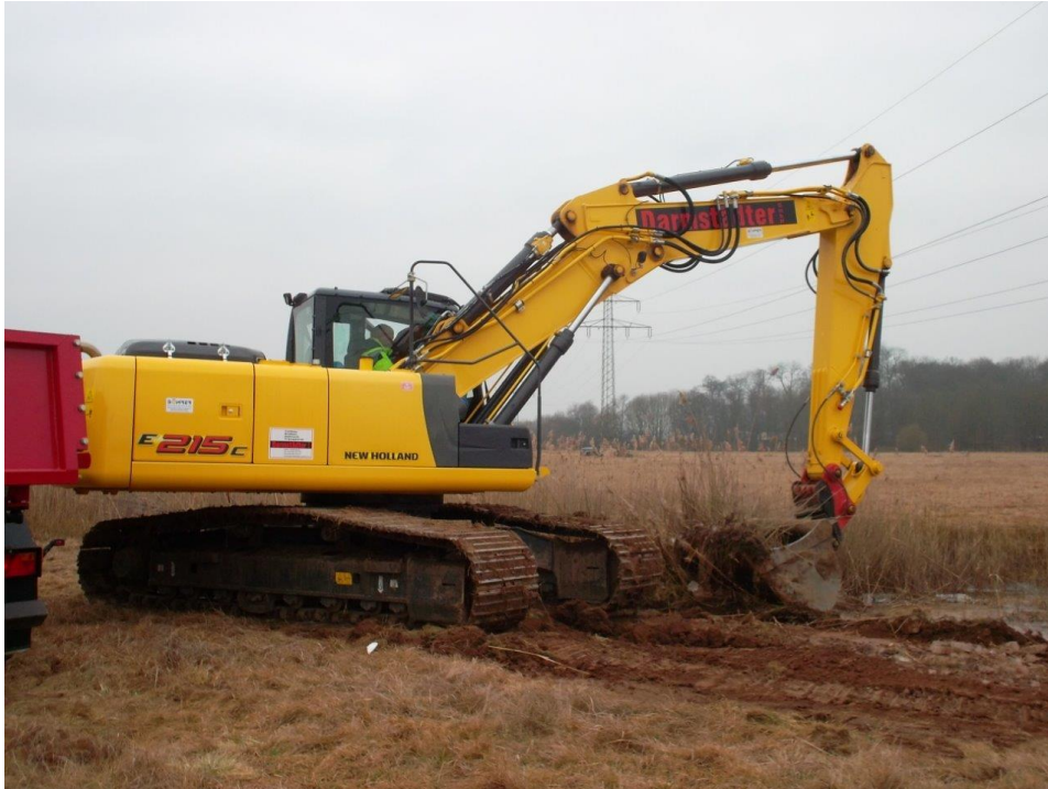
Abb. 70: Die Ufer wurden abgeflacht und ein verlandeter Teil großflächig entschlammt. © GNA
