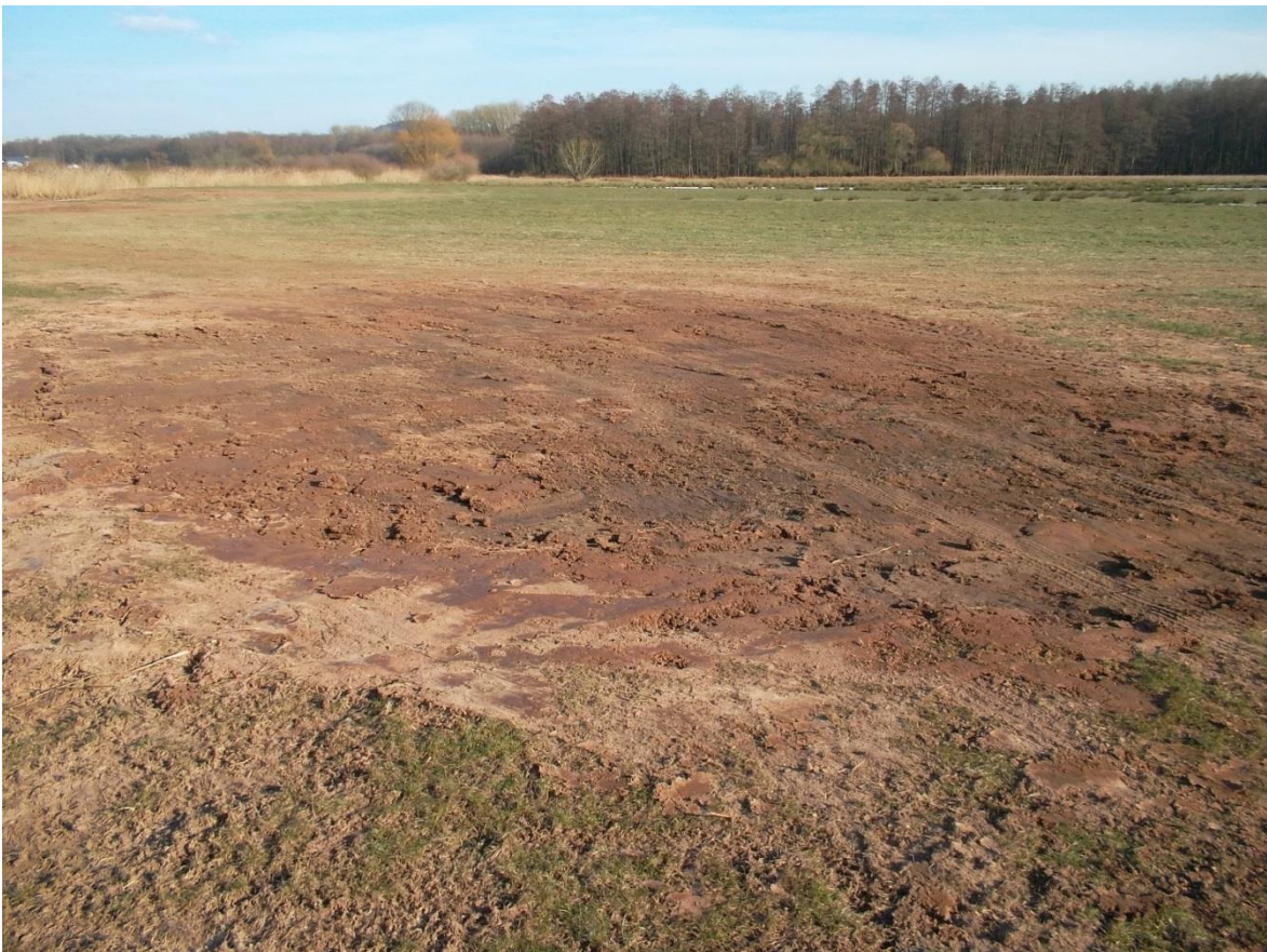
Abb. 89: Nach dem Modellieren der Uferabflachungen wird das restliche Erdmaterial abgefahren. Das Ergebnis sieht man unten. 27.02.2018 © GNA
