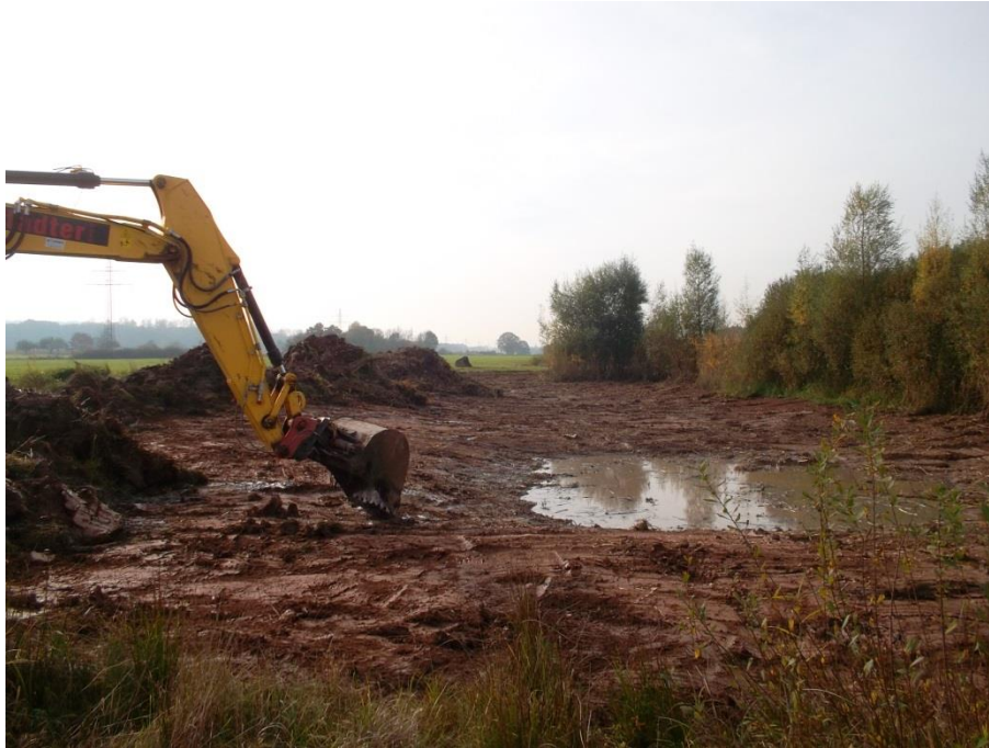
Abb. 62: Baggerarbeiten im November, Neuenhaßlau 2016 © GNA
