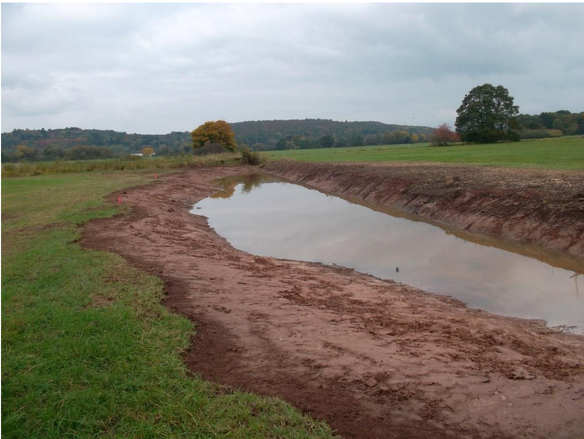
Abb. 56: Die Flutmulden (GW 2) füllten sich nach der Fertigstellung schnell mit Wasser. © GNA
