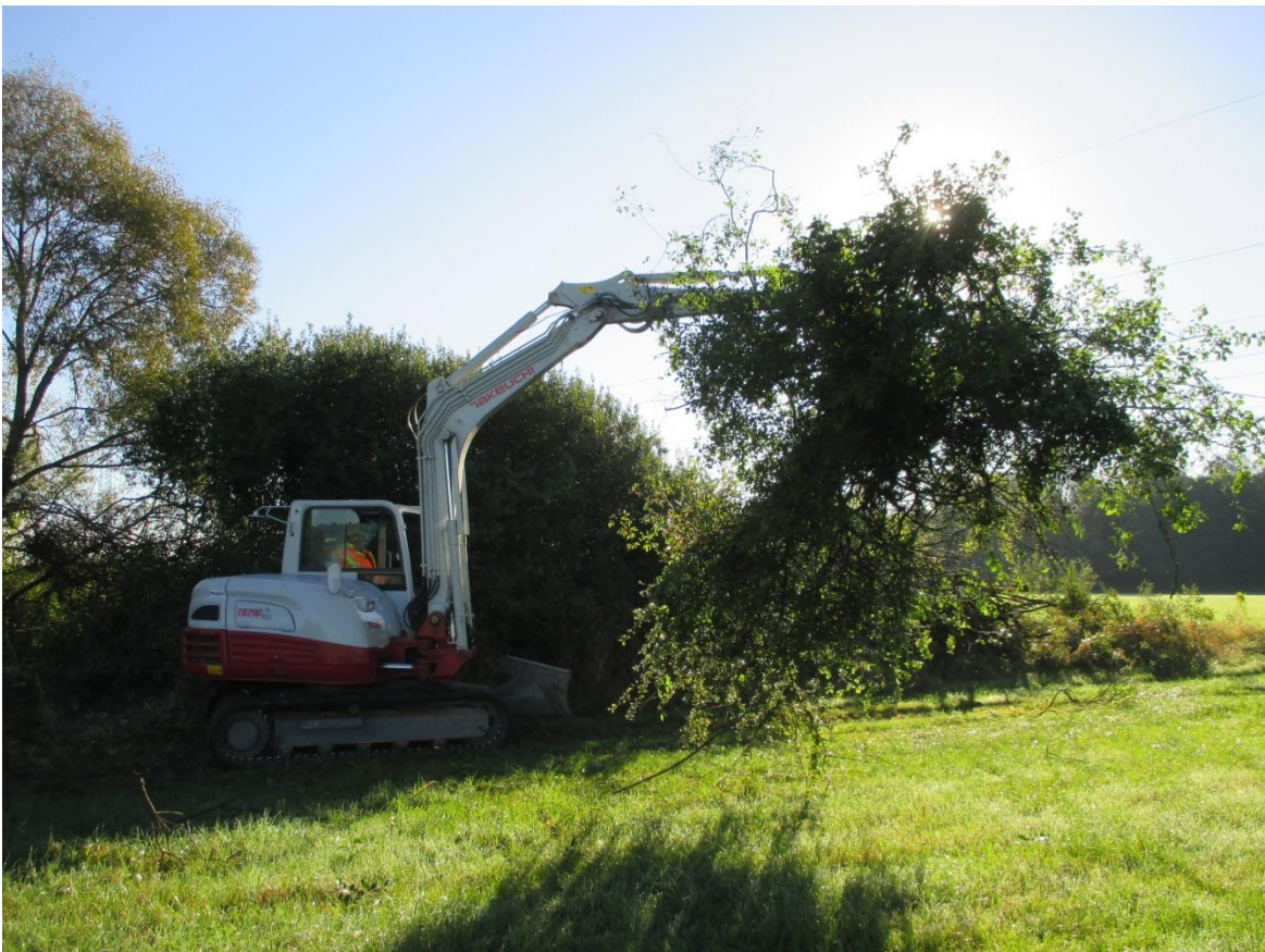
Abb. 48: Die Arbeiten schreiten schnell voran. © GNA
