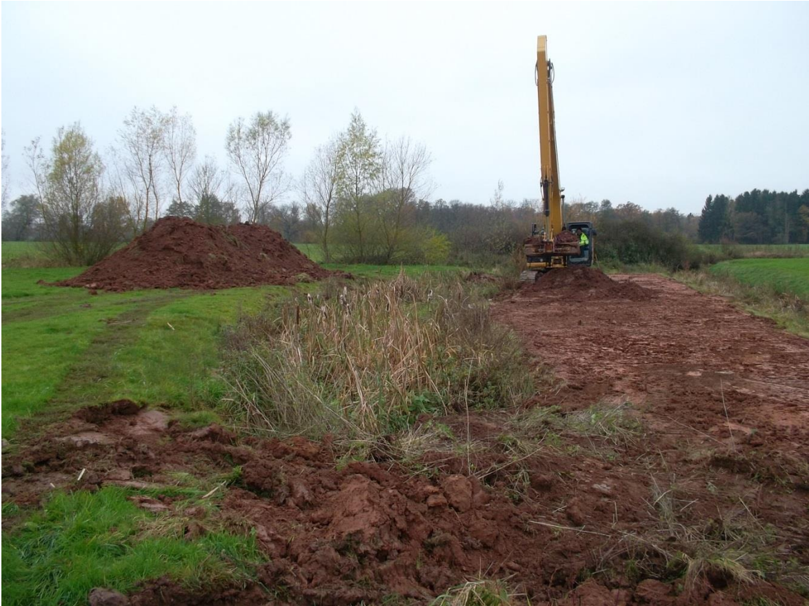
Abb. 85: Die Arbeiten schreiten voran. Der Aushub wird am Bachrand gelagert, da ein Abfahren nicht möglich ist. 16.11.2017 © GNA
