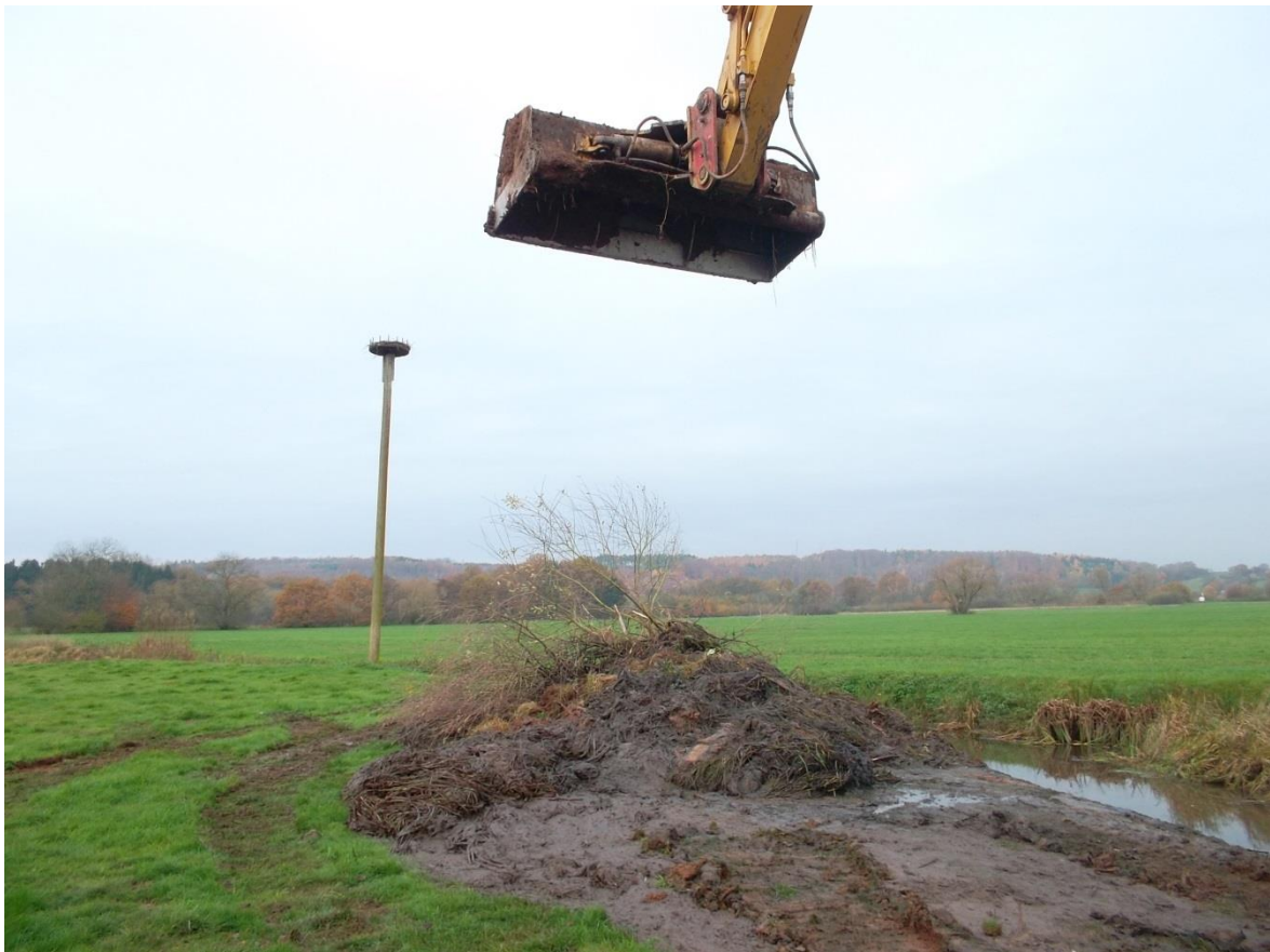
Abb. 79: Der Boden ist auch am 15.11.2017 nur bedingt geeignet. Deshalb kommt ein Langarmbagger mit 80 cm Kettenbreite (anstatt 60 cm) zum Einsatz. Die Arbeiten schreiten zügig voran. © GNA
