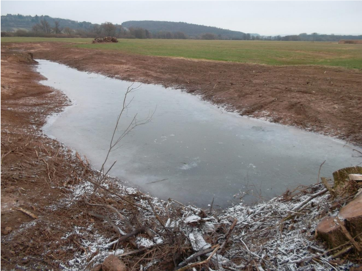
Abb. 59: Der vordere Teil des neuen Gewässerkomplexes 1 nach der Fertigstellung © GNA
