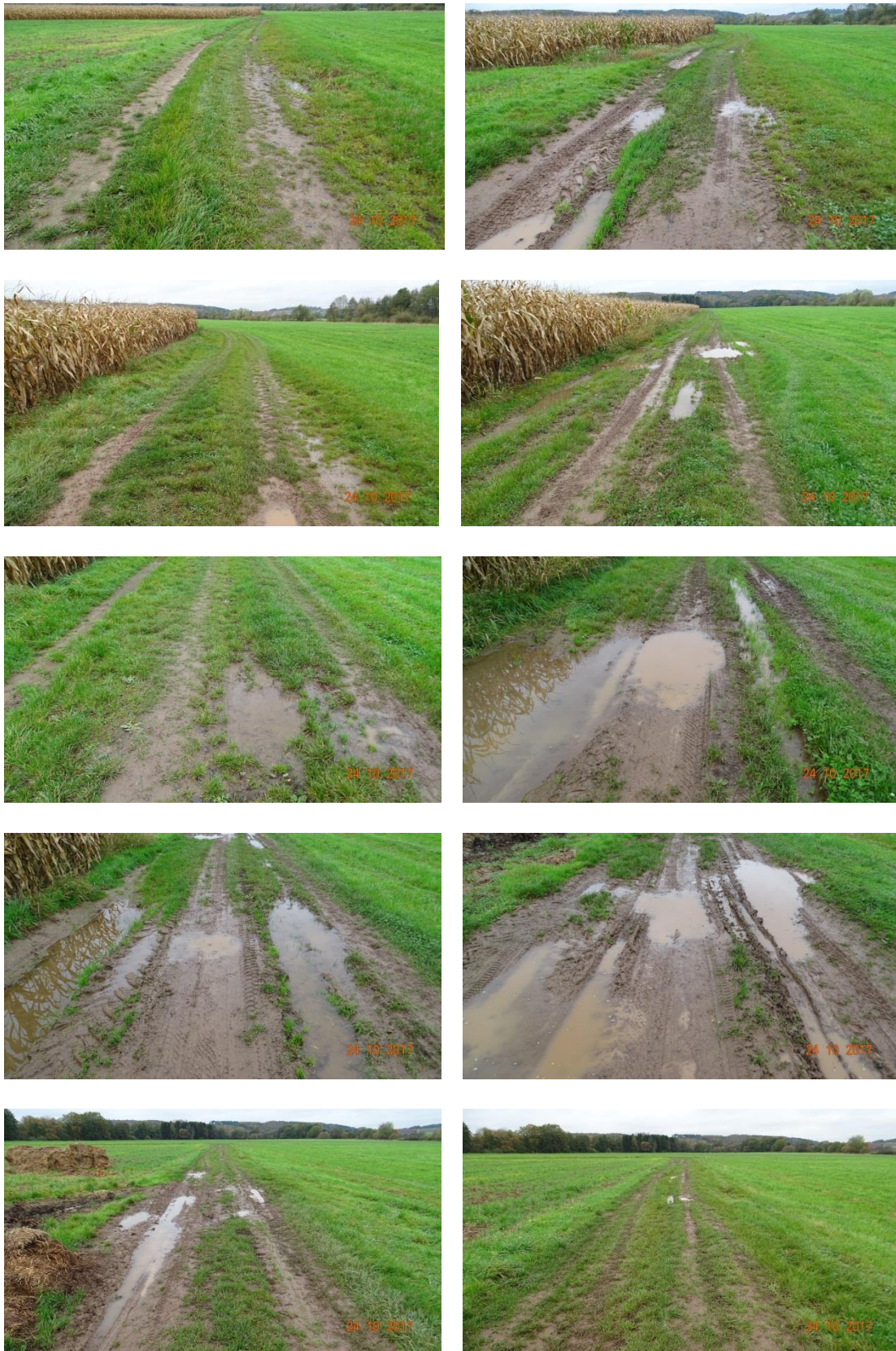
Abb. 75: Die Dokumentation des Zufahrtweges (unbefestigter Feldweg) für die Baustellenfahrzeuge war zwingend notwendig, um spätere Beschwerden und Regressansprüche (Kommune, Landwirte u.a.) ggf. entkräften zu können, da der Weg sich nach Dauerregen und anderweitiger Befahrung per se in einem sehr schlechten Zustand befand. © GNA
