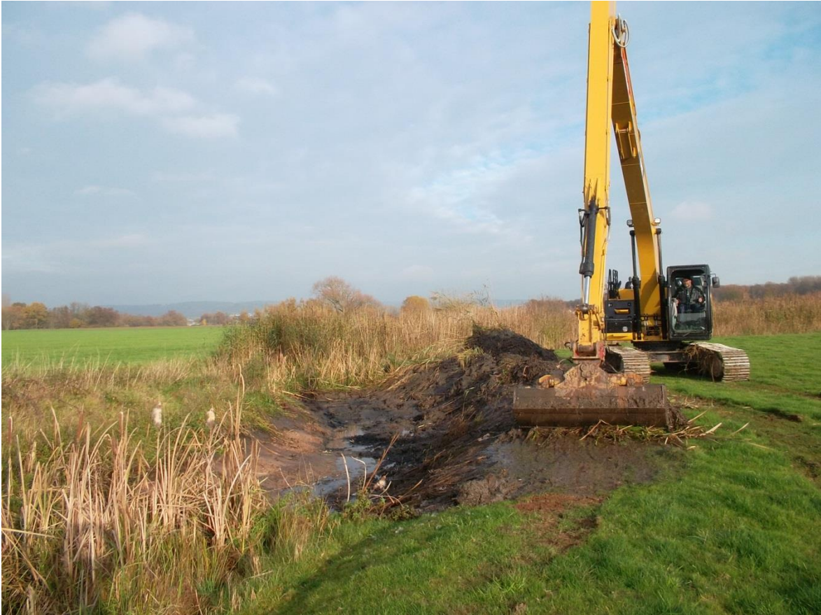
Abb. 78: Der Gewässerkörper wird entkrautet und die Ufer werden abgeflacht 14.11.2017. © GNA
