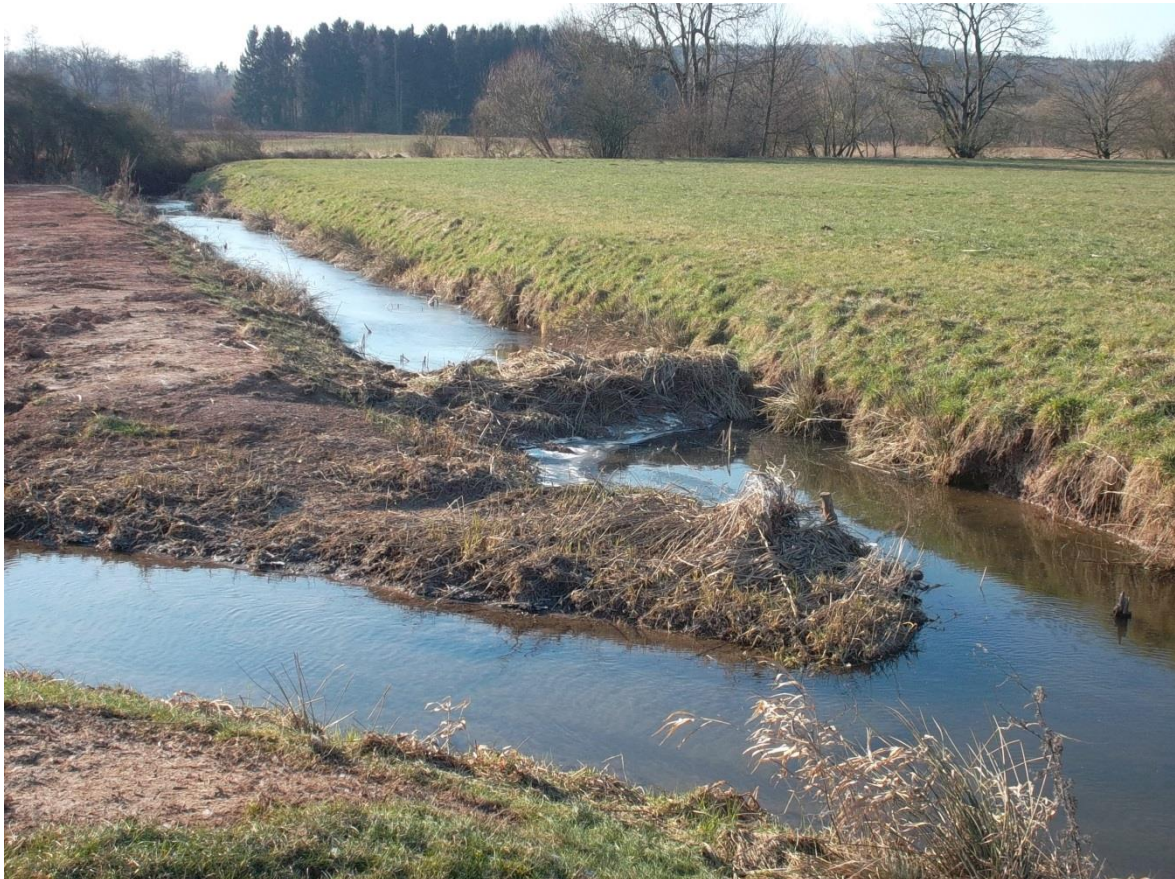
Abb. 88: Der Etwiesenbach ist vollständig entkrautet und die Umleitungsstellen sind hergestellt. 27.02.2018 © GNA
