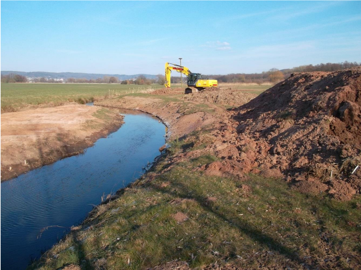
Abb. 89: Nach dem Modellieren der Uferabflachungen wird das restliche Erdmaterial abgefahren. Das Ergebnis sieht man unten. 27.02.2018 © GNA
