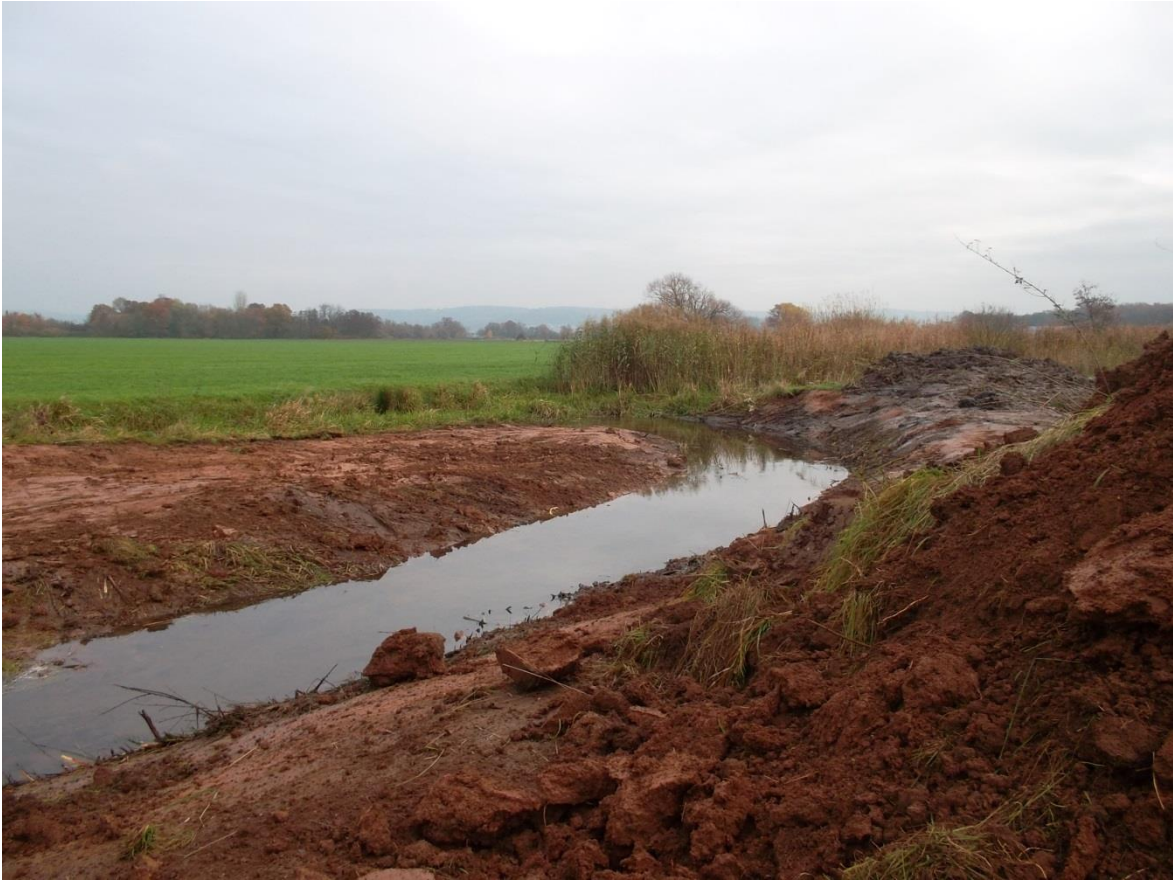
Abb. 80: Der Inselabtrag und der Gewässerlauf werden sichtbar, das Erdmaterial in Absprache mit der UNB am Rand zwischengelagert (s.u.), um Flurschäden zu vermeiden. 15.11.2017 © GNA
