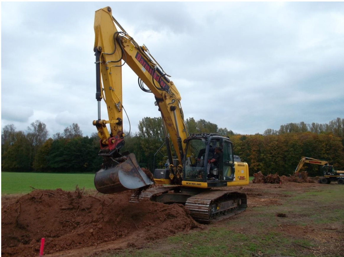
Abb. 52: Mehrere Bagger waren im Einsatz. © GNA
