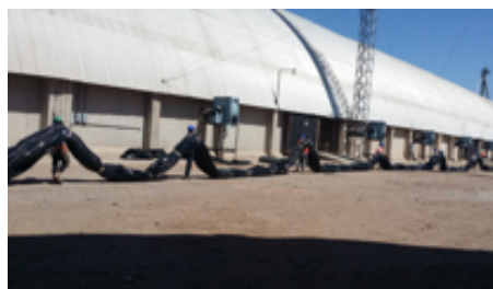
Preparación de las lonas.
