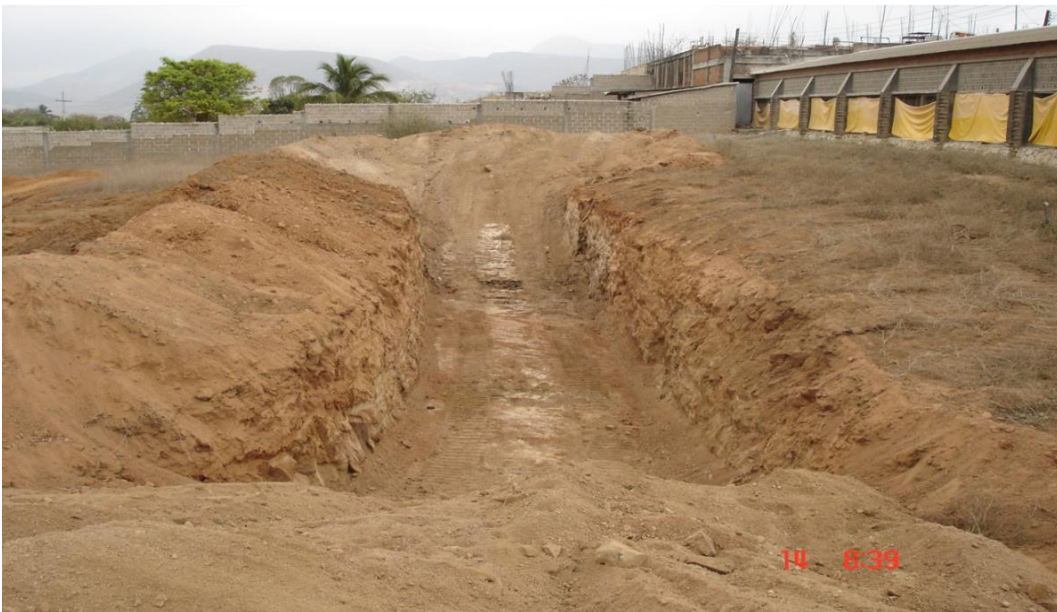
Imágenes de la preparación de la zanja para la disposición sanitaria.
