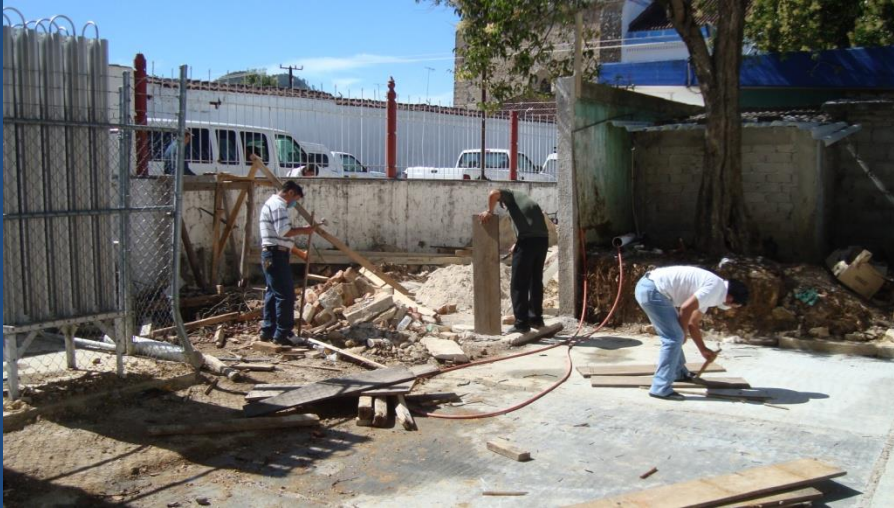
Lunes 20.07.09 Se iniciaron trabajos para abrir el área de triage apartada del área de urgencias del hospital
