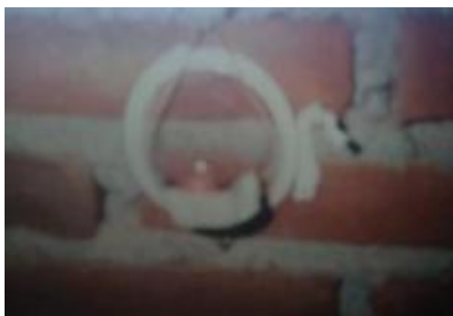
Figura 65. Cono en pared de tabique.
