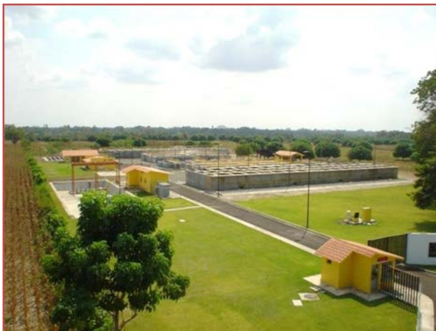
Figura 6.7. Fotografía Planta de Tratamiento de Aguas Residuales Sur-Oriente
