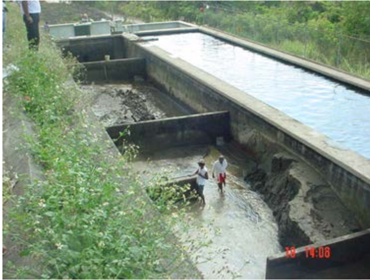
Figura 6.1. Tanque sedimentador
