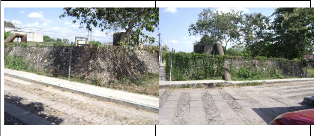
Figura 6.6. Fotografía Tanques gemelos de mampostería
