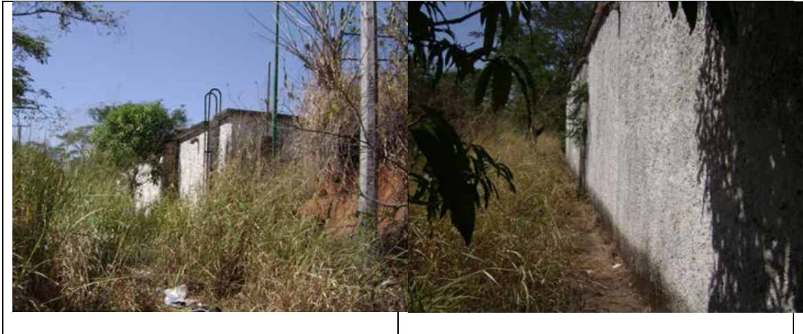
Figura 6.4. Fotografía Tanque de regulación No. 2
