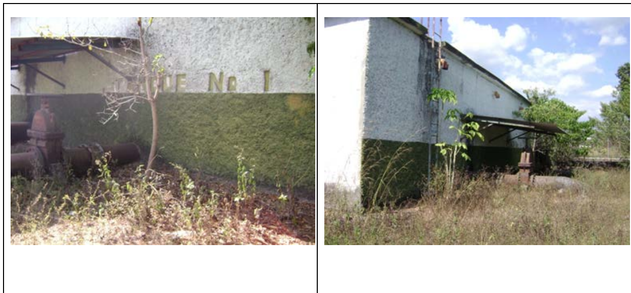
Figura 6.3. Fotografía Tanque de regulación no. 1
