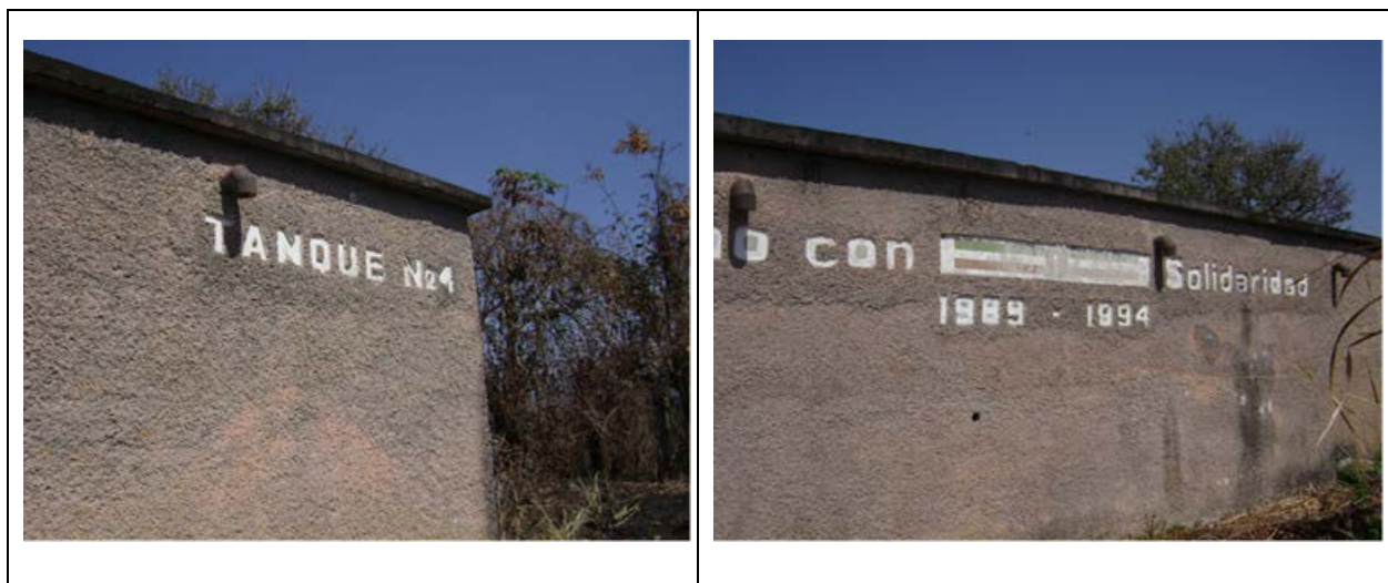
Figura 6.5. Fotografía Tanque de regulación No. 4
