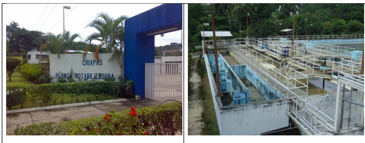
Figura 6.2 Fotografía Planta potabilizadora
