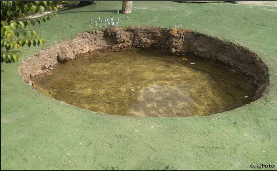
Hundimientos y colapsos
