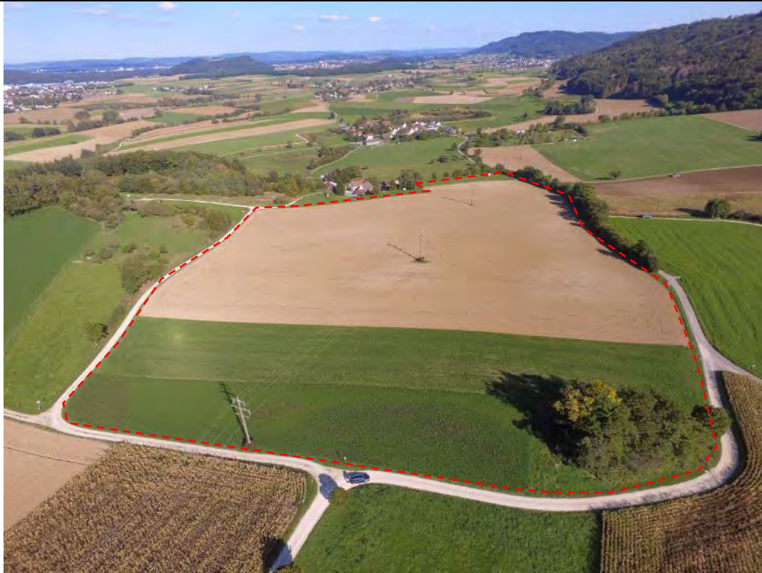
Kaltenbach (P8) Westansicht des gesamten Standorts mit Stromtrasse, vorhandene Wirtschaftswege umschließen die Fläche, rechts im Vordergrund das Feldgehölz Häußeler, außerhalb liegt eine Hofstelle, im Bildhintergrund die Siedlung Murbach
