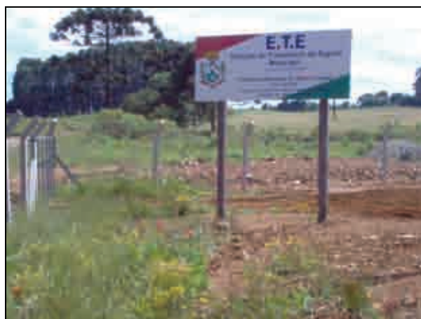
Figura 2.5-11: Estação de Tratamento de Esgoto do Município de Muitos Capões
