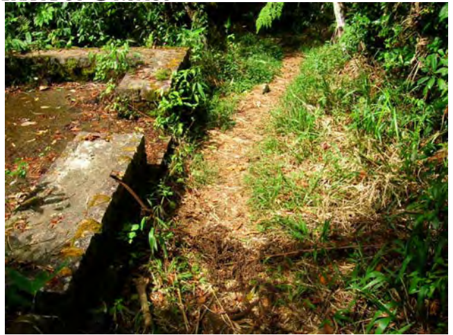
Foto 2 – Detalhe da caixa d'água (cisterna) entre, P2 e P3.
