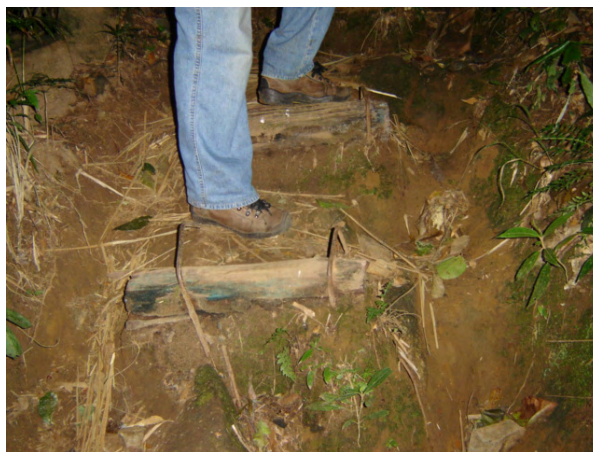
Foto 2 – Detalhe da formação dos sulcos nas laterais dos degraus e conseqüente perda de solo, ente P14 e P15.
