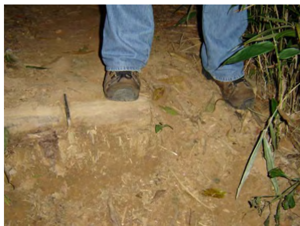
Foto 4 – Desvio do traçado da trilha para fora do comprimento dos degraus, situação comum nos cotovelos da trilha..
