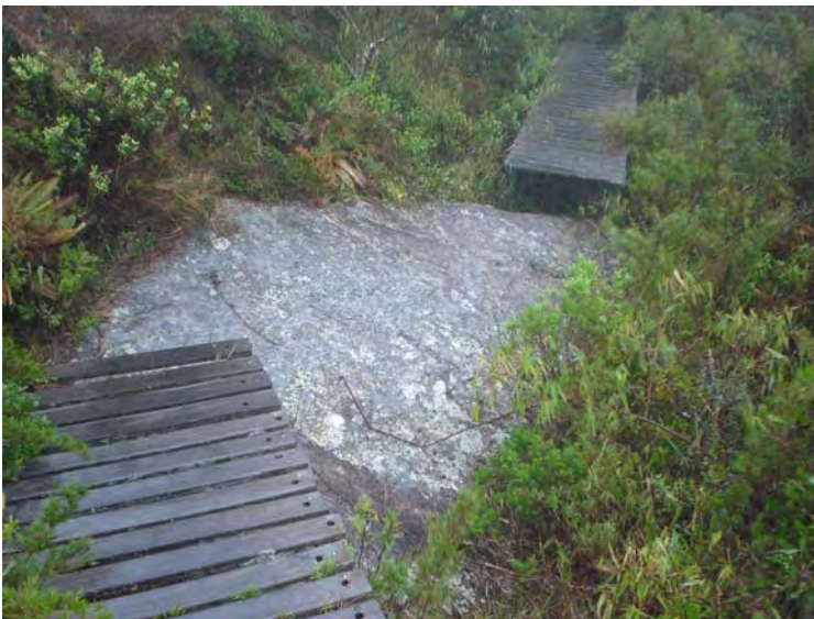
Foto: pontes do morro elevador, não apresentam corrimão.
