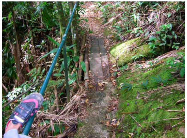
Foto 4 – Ponte, entre P8 e P9, observar o material do revestimento combinando madeira e cano.
