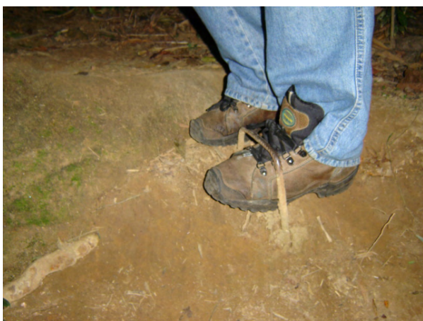
Foto 5 – Com a perda de degrau, o vergalhão de fixação pode se tornar um obstáculo. Situação observada ocasionalmente na trilha.
