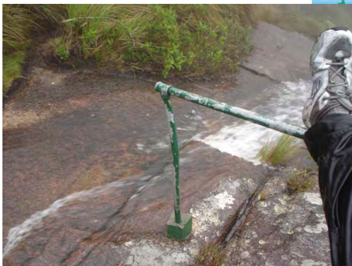
Foto Corrimão quebrado e agora ausente para a travessia de curso de água
